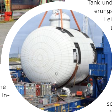
GIGANT. Der 500 m 3 fassende LNG-Tank bei seiner Ankunft in Bremerhaven.
