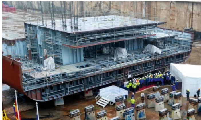
RUMPF. Der erste Stahlblock der neuen „Mein Schiff 2“ wurde Anfang Oktober bei Meyer Turku ins Trockendock gehoben.
