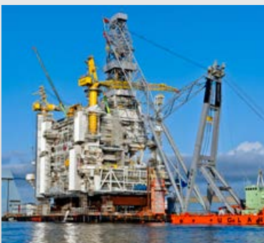
VIELSEITIG. Palfinger liefert auch für Offshore-Anlagen Equipment wie Krane oder Winden.
