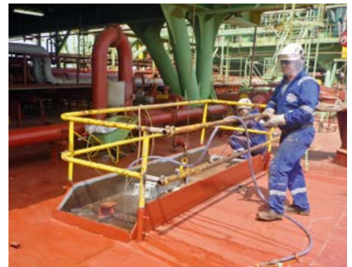
GESCHULTES PERSONAL. Muehlhan-Mitarbeiter beim Kaltschneiden von Stahl mittels Ultrahochdruckwasser auf einem FPSO vor der westafrikanischen Küste.
