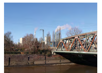
Ausbaggerarbeiten verzögern sich. Foto: Stefan Lorenz
