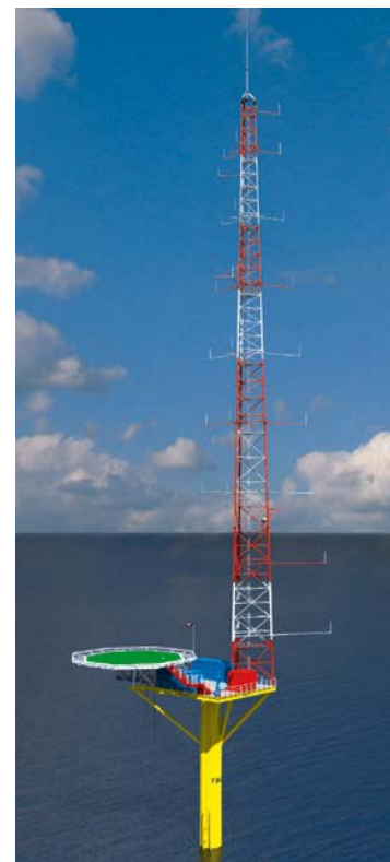
FINO3. Die Forschungsplattform steht 80 Kilometer westlich der Nordseeinsel Sylt.
