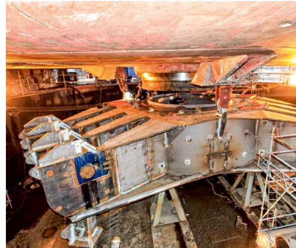
AUFRÜSTUNG. Drehturm und Turret-Ankersystem wurden verbessert, um die Sicherheit und die Förderquote der Einheit zu erhöhen.
