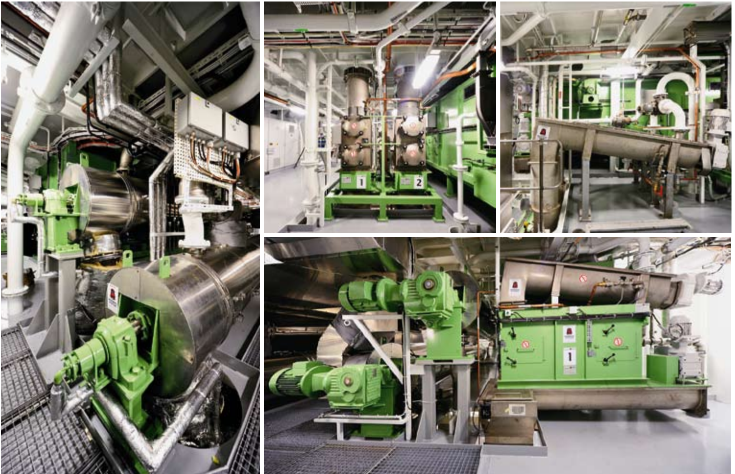
Zentrale: Im Müllverbrennungsraum werden Speisereste entwässert, getrocknet und für die Verbrennung vorbereitet.
