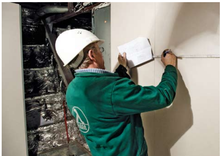
Montage einer Crew-Kabine auf einem Passagierschiff – R&M ist in hohem Maße lieferfähig. Das sichert eine punktgenaue Ablieferung.
