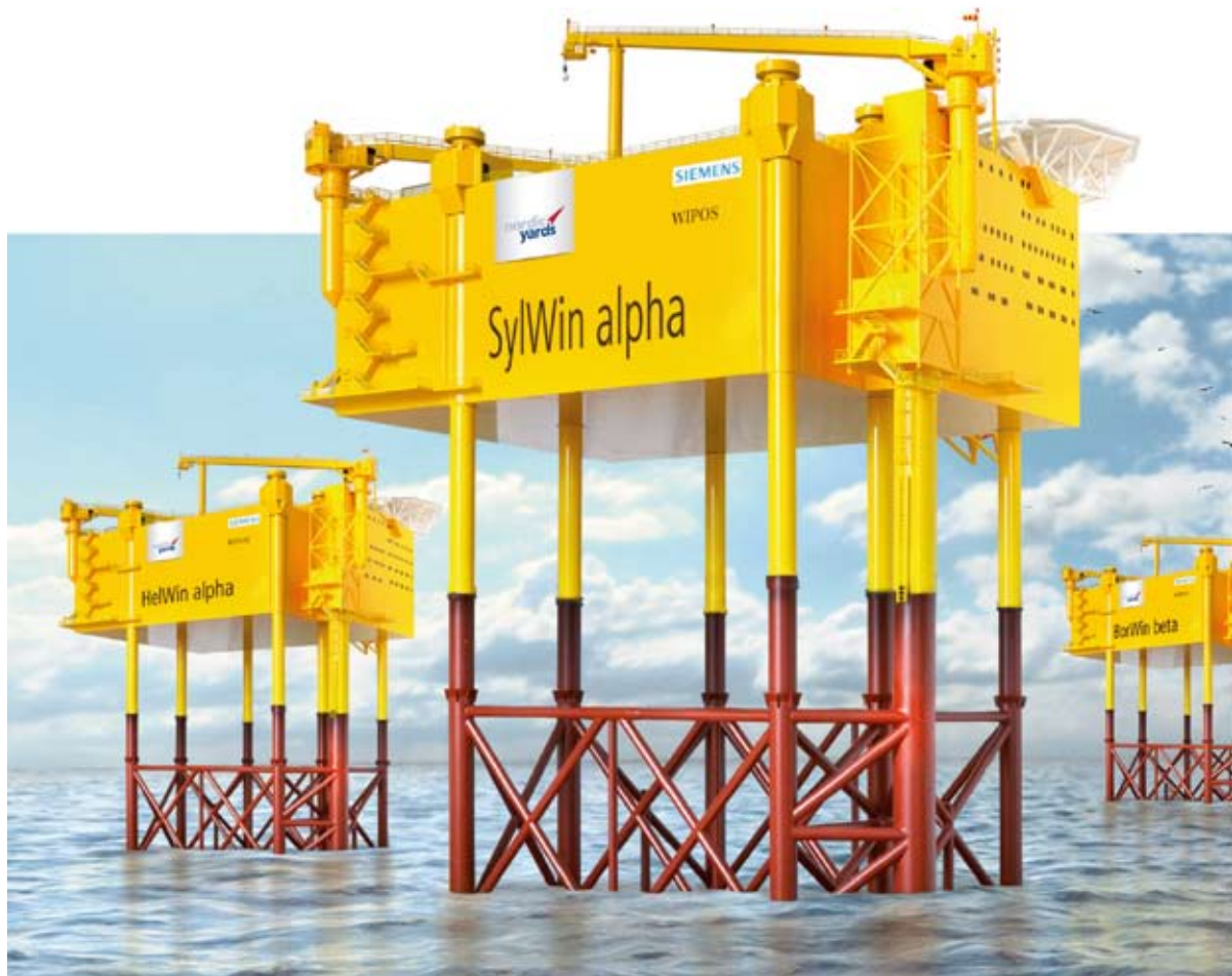
Nordic goes offshore: Bei der Werftengruppe entstehen derzeit die drei Konverterplattformen BORWIN BETA, HELWIN ALPHA und SYLWIN ALPHA, die zukünftig jeweils bis zu 864 Megawatt Strom von Windparks in der Nordsee umwandeln und weiterleiten werden.
