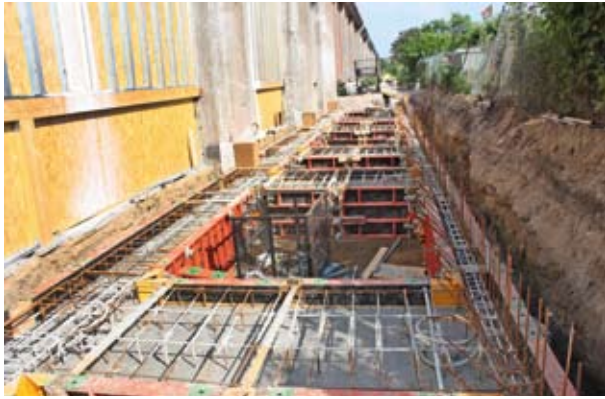
Fundament für das Stausystem
