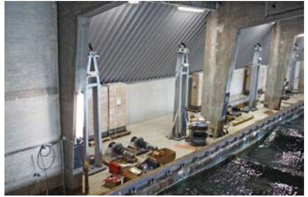
Installation des Stausystems
