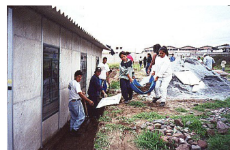
Foto: Bau der Schule - Peaby-Projekt, Ecuador
