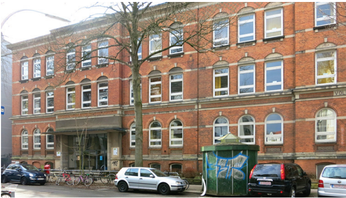
Schulgebäude Schwenckestraße 91 - 93 (Foto: D. Schlanbusch)
