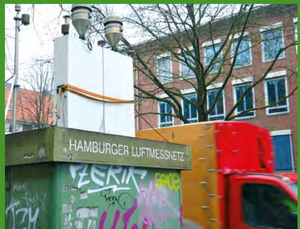
Luftmessstation an der Barmbeker Habichtstraße
