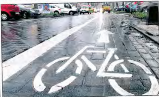
Nach den verbindlichen Hamburger „Planungshinweisen für Stadtstraßen“ (PLAST 9) müssen Radfahrer vorrangig auf Radfahrstreifen geführt werden, und nicht auf Radwegen. Foto: Archiv
