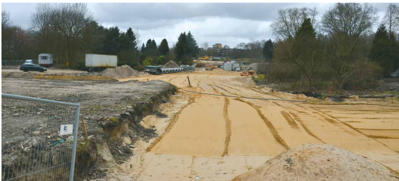
Im Zentrum des Baugebietes bleiben alte Bäume bestehen. Dazwischen wird die künftige Anliegerstraße gebaut.
