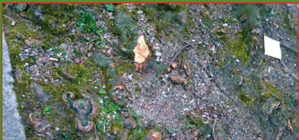
Wird auf dem Grünstreifen geparkt, führt das Rangieren zu Schäden an oberflächennahen Wurzeln
