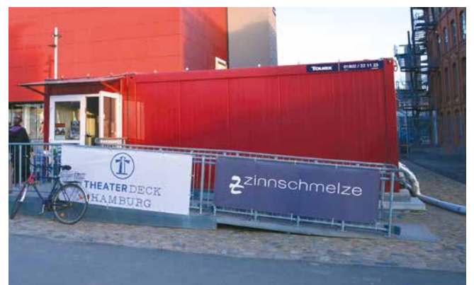
Während des Umbaus der Zinnschmelze fanden in der „Umbaubude“ kleine Veranstaltungen und Cafébetrieb statt
