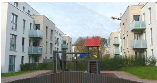
Geförderte Neubauten der SAGA GWG Am Weißenberge in Ohlsdorf
