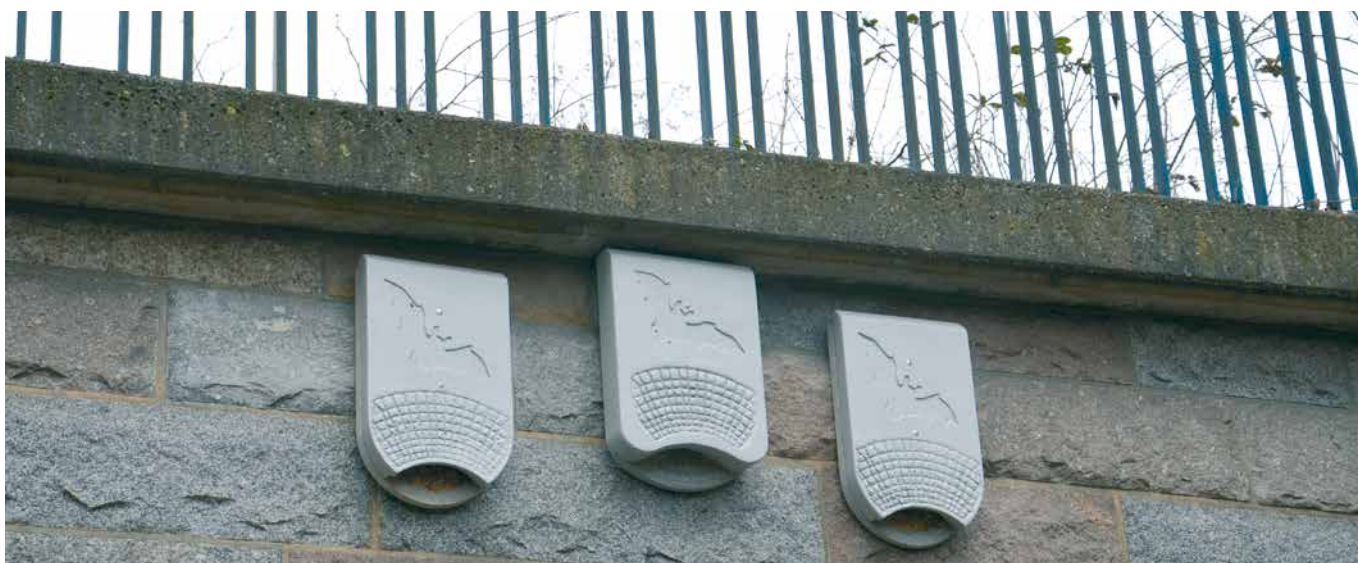
Zum Ausgleich für durch die Baumaßnahmen potenziell verloren gegangene Fledermausquartiere wurden schon im Vorfeld an nahegelegenen Brücken Fledermauskästen angebracht.
