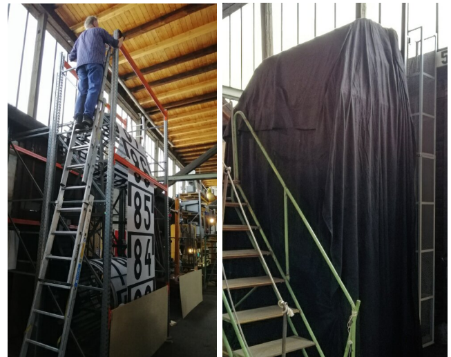
Oben links: Arbeiten an der provisorischen Einhausung mit Stahlrahmen und Hartfaser
