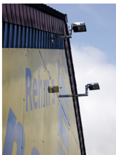
Abb. A10: Außenbeleuchtung eines Lebensmittelgeschäfts in Hilders bei Tag. Die Strahler an der Fassade haben einen engen Lichtkegel und strahlen ausschließlich nach unten. Die Leuchtstoffröhre wurde zu den Seiten abgeschirmt. Fotos: Andreas Hänel.
