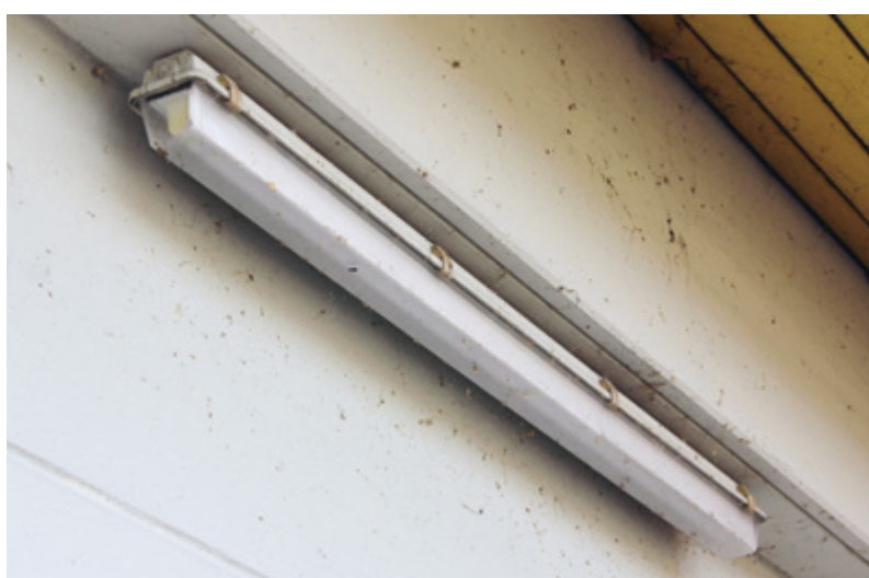
Abb. A10: Außenbeleuchtung eines Lebensmittelgeschäfts in Hilders bei Tag. Die Strahler an der Fassade haben einen engen Lichtkegel und strahlen ausschließlich nach unten. Die Leuchtstoffröhre wurde zu den Seiten abgeschirmt. Fotos: Andreas Hänel.
