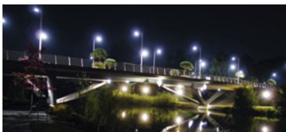
Abb. 9: Lichteinfall auf Gewässern – etwa durch nicht abgeschirmte Brückenbeleuchtungen – können Wanderbewegungen von Fischen unterbrechen und aquatische Insekten beeinträchtigen. Foto: Reinhold Schaal
