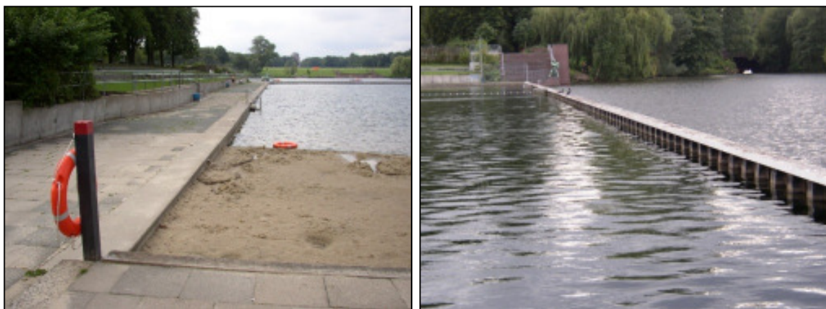
Abbildung 19: Links: Nichtschwimmerbereich mit Sandstrand am Südufer. Rechts: Spundwand als Abgrenzung zwischen Freibad (links) und Stadtparksee (rechts).
