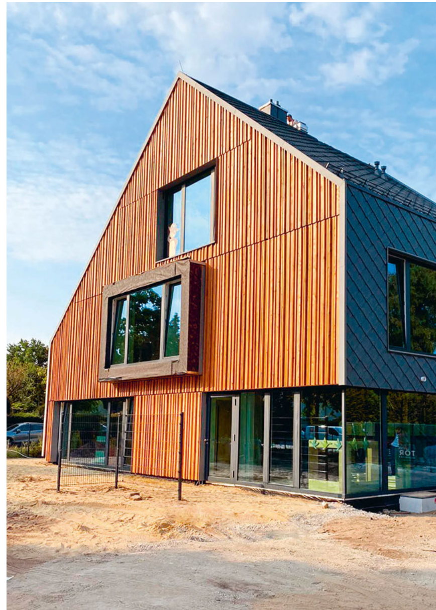
Es steht! Das neue Mehrgenerationenhaus der Erika und Ilse Töllke Stiftung (siehe auch Artikel ab Seite 8) in Schnelsen ist ein Vorzeigebispiel für die Anlage in Immobilien und die Förderung eines Stadtteils und seiner Bewohner
