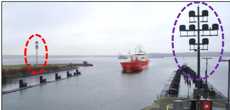
Abbildung 39: Signalstellen (Einfahrten in die Zufahrt und in die Neue Schleuse)
