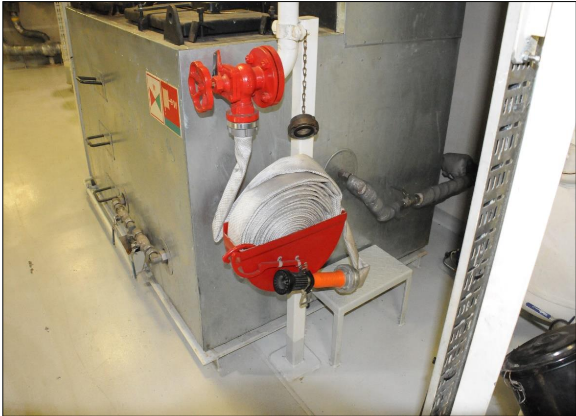
Abbildung 25: Standard - Strahlrohr / Hydranten System
