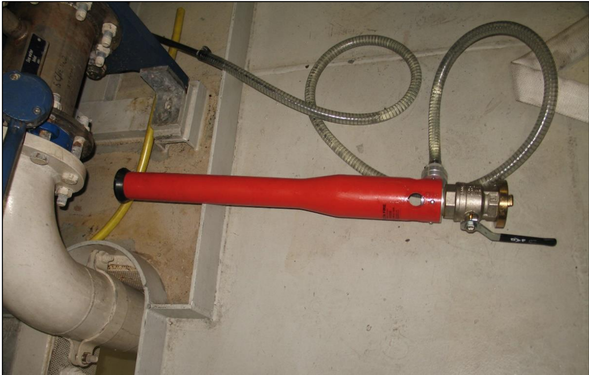
Abbildung 27: mobiles Schwerschaumrohr mit integriertem Zumischer
