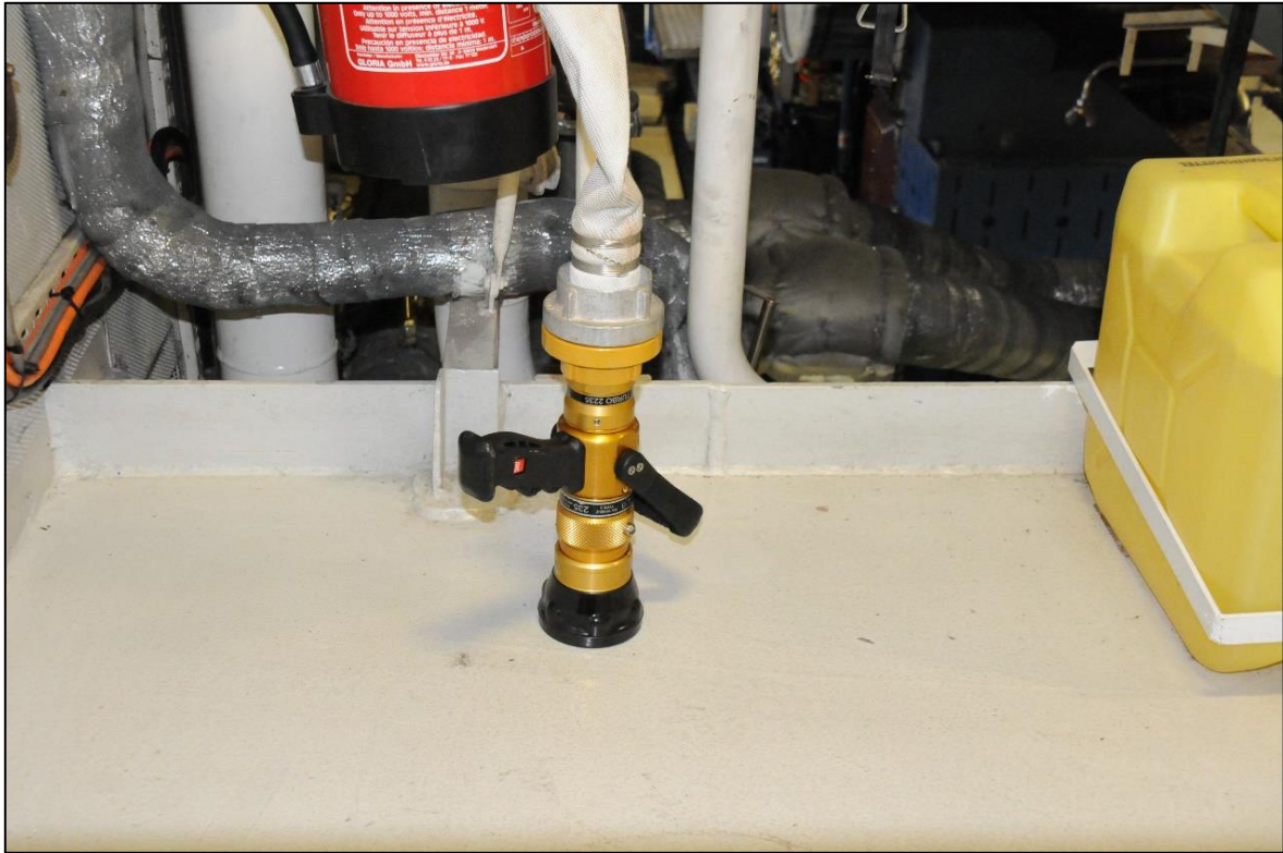
Abbildung 43: Turbo-Strahlrohr 60/130/235l/min
