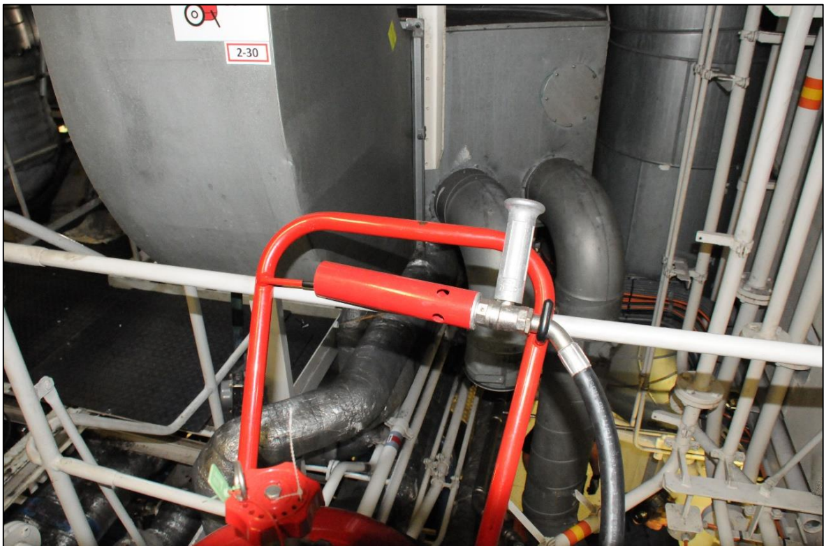
Abbildung 33: Schwerschaumrohr (Trolley) für Entstehungsbrandbekämpfung
