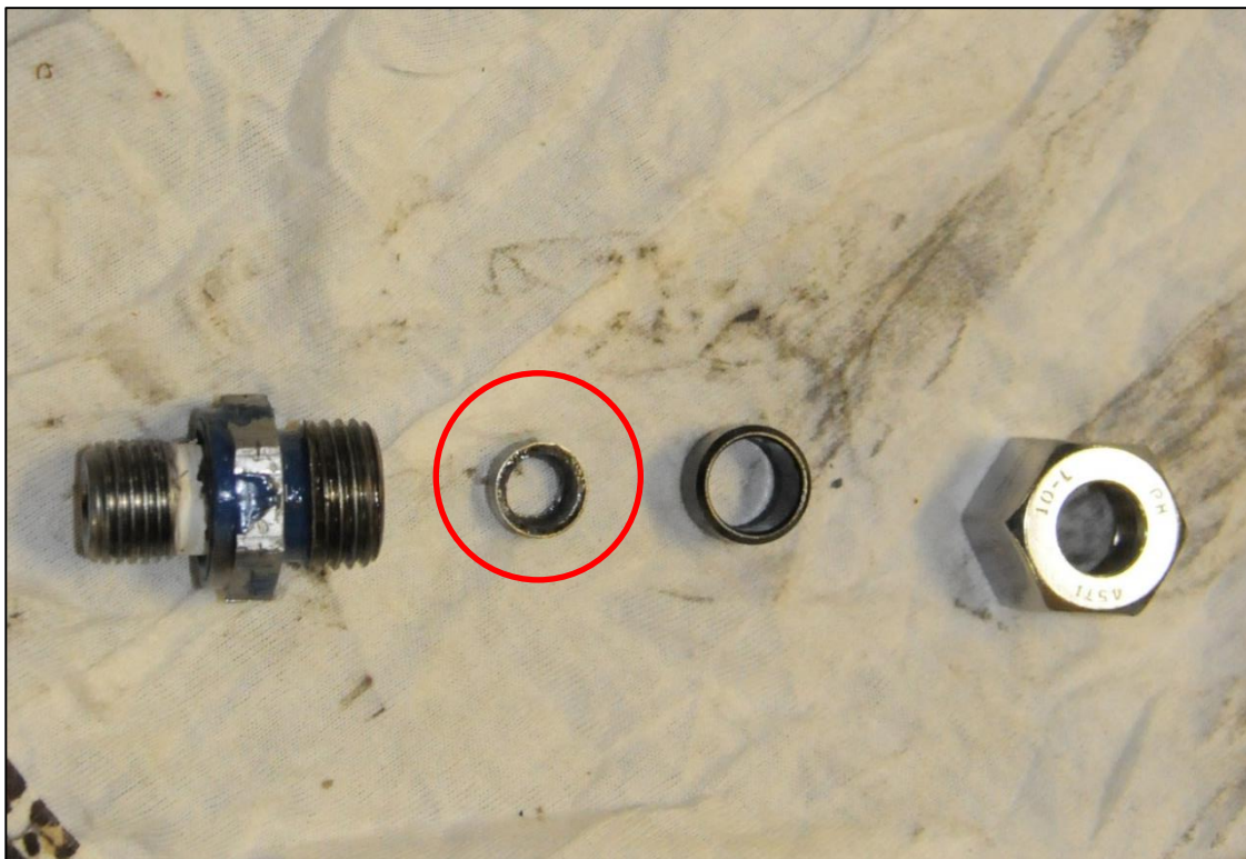
Abbildung 14: Verschraubung mit abgebrochenem Rohrleitungsstück
