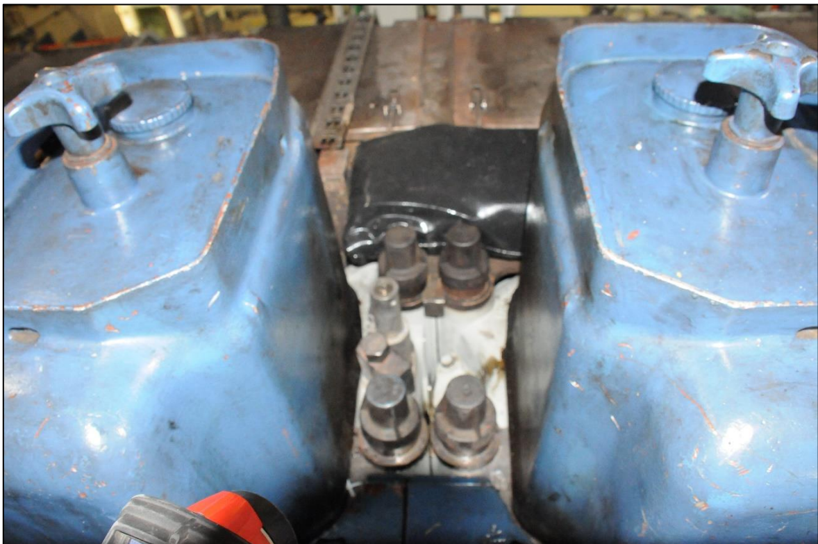
Abbildung 42: Isolierung Übergang Zylinderstation/ Abgaskanal
