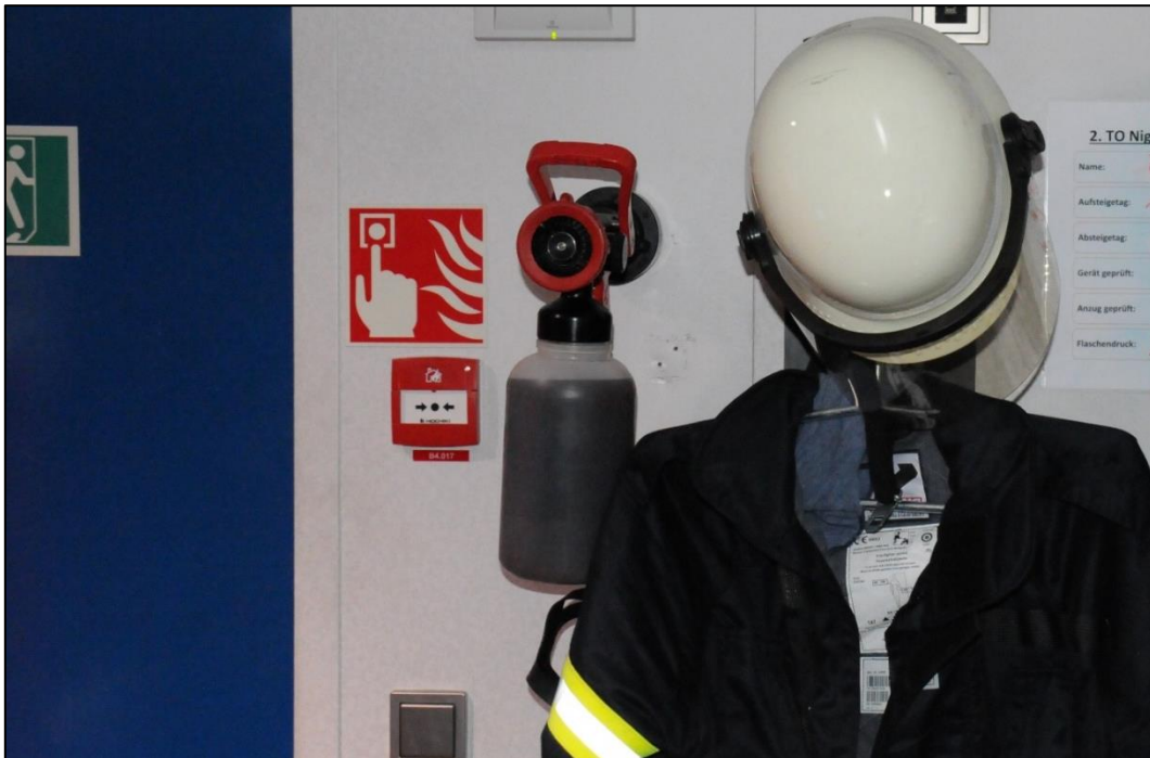
Abbildung 34: Venturi-Turbostrahlrohr mit 2 l F-500 EA zum flexiblen Erstangriff in allen Maschinenbereichen, positioniert im Engine Fire Locker (Brandabwehrausrüstungsraum)
