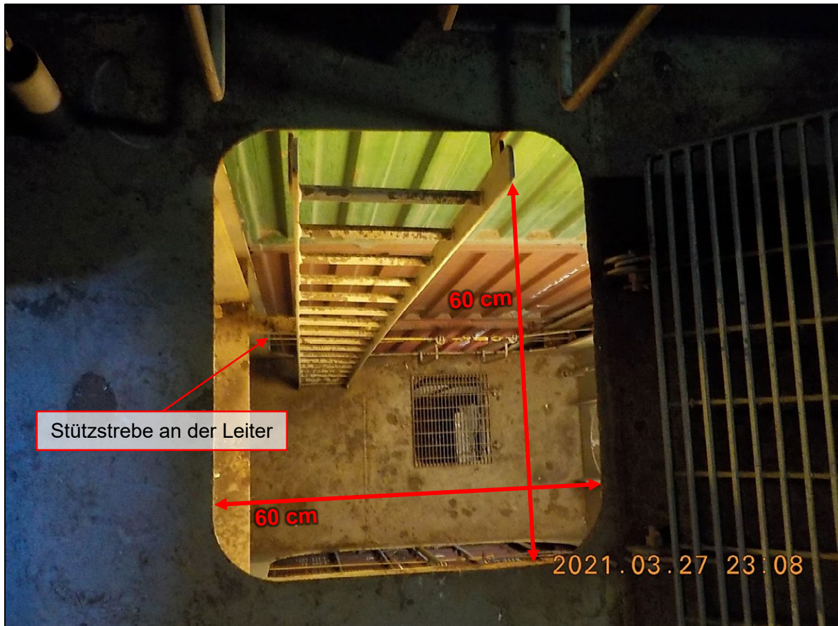
Abbildung 11: Blick vom 2. Deck auf das 2. Stringer Deck 52
