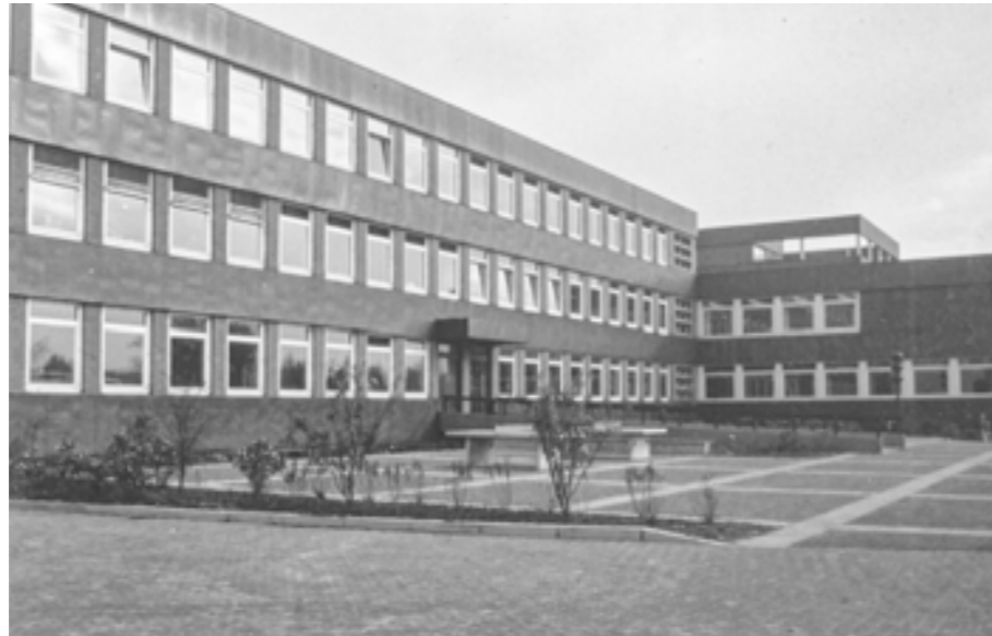
Nach drei Jahren Bauzeit kann die Hamburger Werkstatt in der neuen Zentralwerkstatt am Südring im November 1976 die ersten Räumlichkeiten beziehen.
