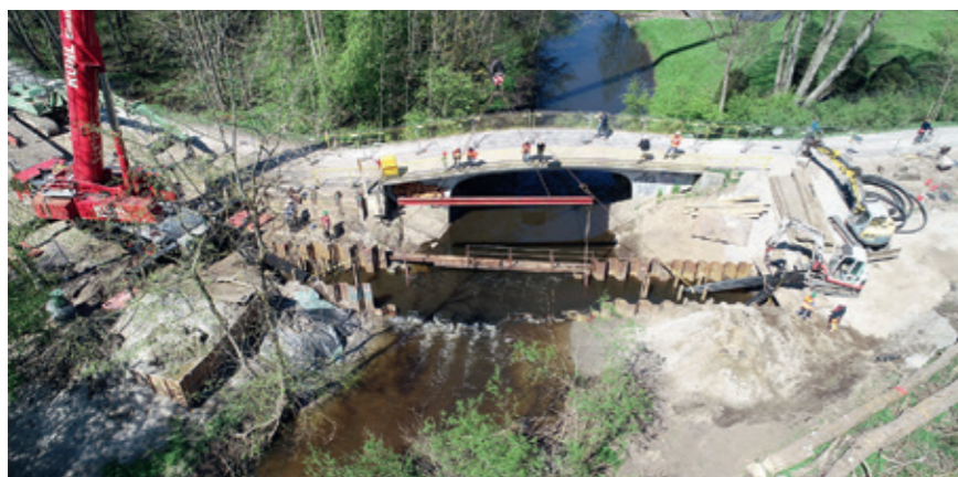
Luftbilder mittels Drohne vom Bauzustand des Neubauwerks.
