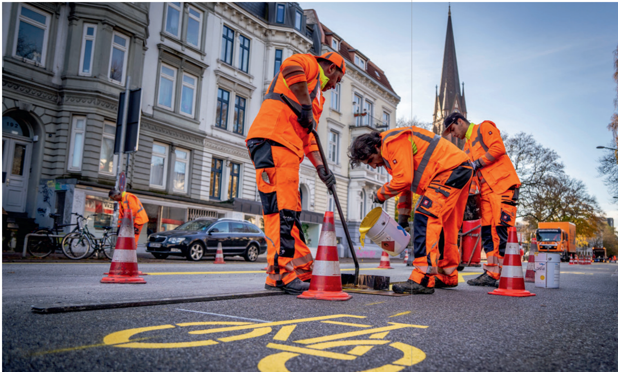
Markierungsarbeiten an der Pop-Up-Bikelane Max-Brauer-Allee.
