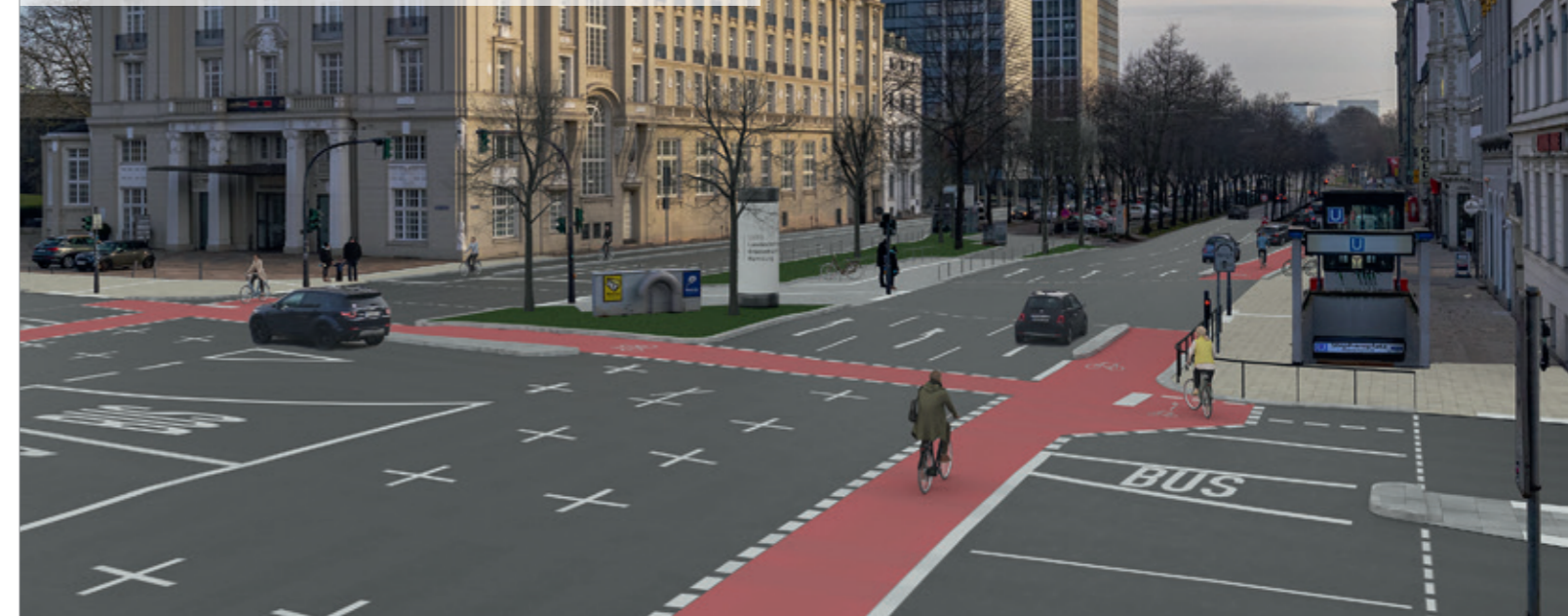
Bei der Sanierung der Esplanade berücksichtigte der LSBG die Bedürfnisse aller Verkehrsteilnehmer:innen.
