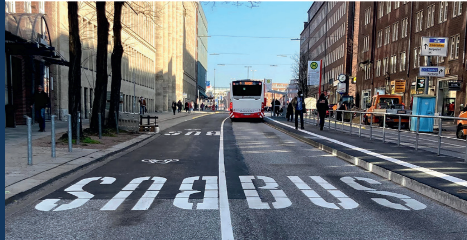
Die neu eingerichtete provisorische Mittelhaltestelle im Bereich der Jakobi-Kirche.
