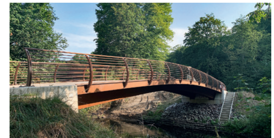
Die neue Grevenaubrücke aus wetterfestem Baustahl.
