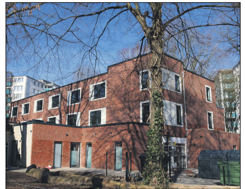
Der Neubau in der Elbgaustraße ist gut an die öffentlichen Verkehrsmittel angeschlossen. Die Kinderschutzgruppe ist in der zweiten Etage beheimatet, unten gibt es eine Kita. Der Außenbereich wird noch begrünt und mit Spielgeräten für die Kinder ausgestattet. Fotos (2): Bormann
