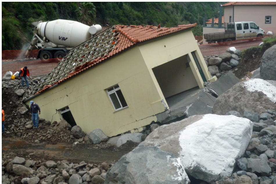
Der Erdbeben hob ein Garagenhaus samt Fundament und riss es fort
