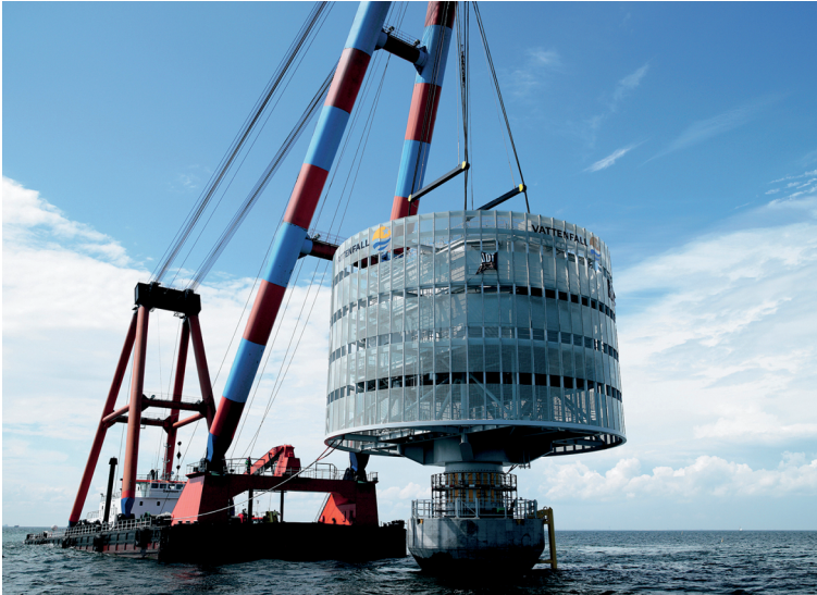
Abb. 2: Installation einer Umspannstation in der Nordsee (Foto: Bernd Ellerbrock).
