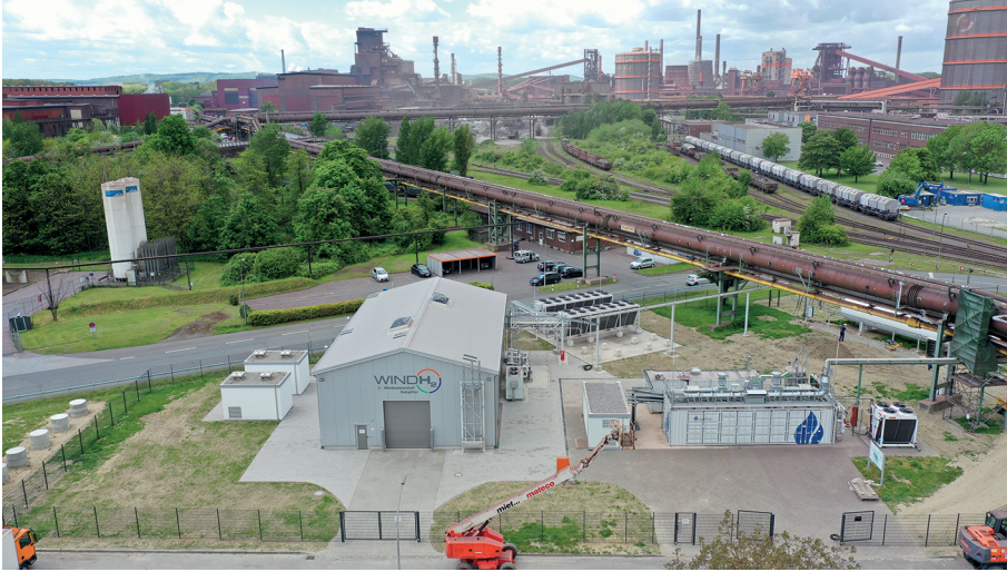
Abb. 2: WindH2, Salzgitter AG (Foto: Salzgitter AG).
