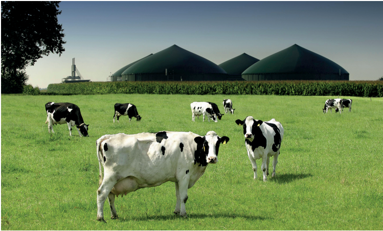
Abb. 3: Biogasanlage Godenstedt (Landkreis Rotenburg) (Foto: Bernd Ellerbrock).
