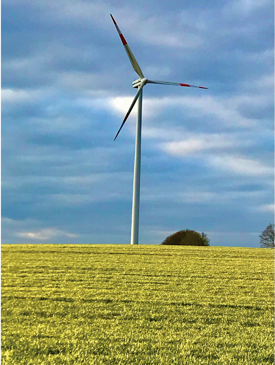
Abb. 6: Windkraftanlage im Landkreis Lüneburg (Foto: Arno Brandt).
