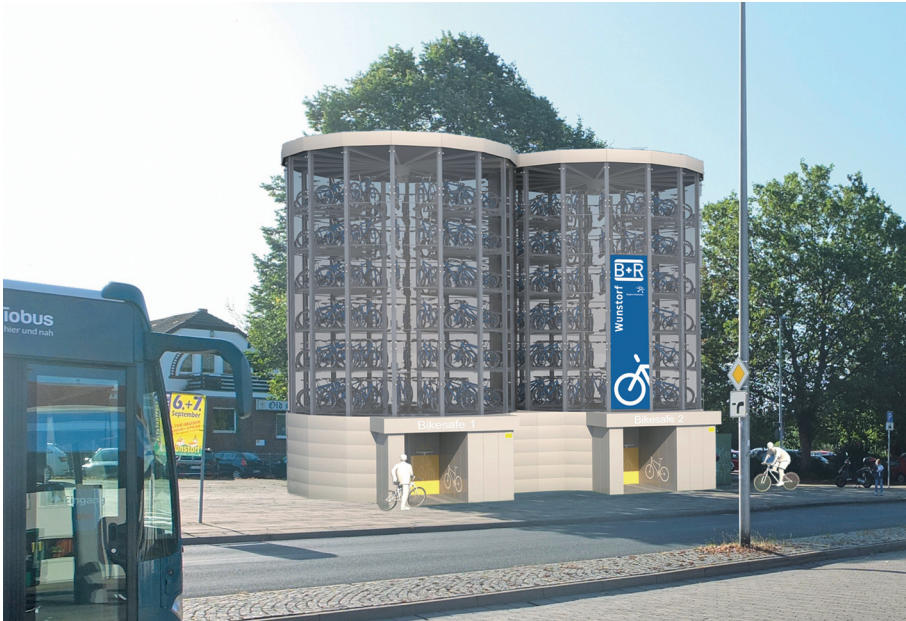
Abb. 4: Am Bahnhof Wunstorf entstehen zwei Fahrradtürme mit Platz für fast 300 Fahrräder (Foto: Region Hannover).
