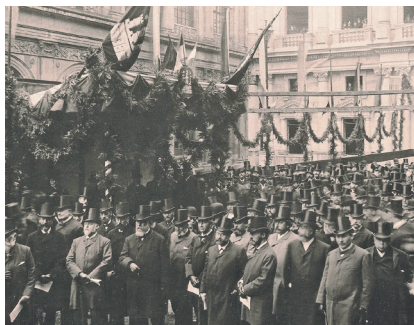
Mann trägt Zylinder. Herren unter sich beim Richtfest am Sonnabend, den 7. Mai 1892. Foto © Staatsarchiv
