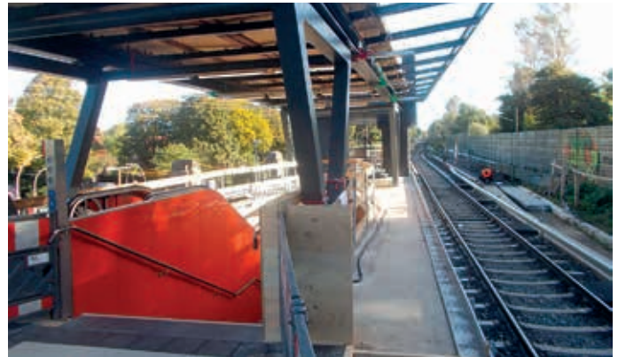
Der Zugang vom Bahnsteig zum Aufzug (rechts zwischen Treppe und Gleis ist noch ohne Schutzgitter)
