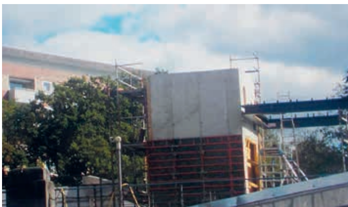
Der Aufzugschacht mit den sich anschließenden Trägern für das Bahnsteigdach. Das deutet darauf hin, dass das Treppenhaus wohl keine geschlossenen Seitenwände erhält, was bedeutet, dass kaum ein Wetterschutz auf den Stufen vorhanden ist, denn der Bahnsteig liegt quer zur Hauptwetterrichtung, so dass der Niederschlag von der Seite hereingetrieben wird.
