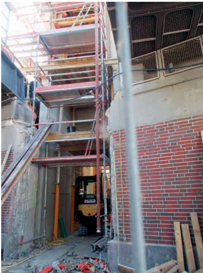
Der Zugang zum noch einzubauenden Aufzug von der Hindenburgstraße
