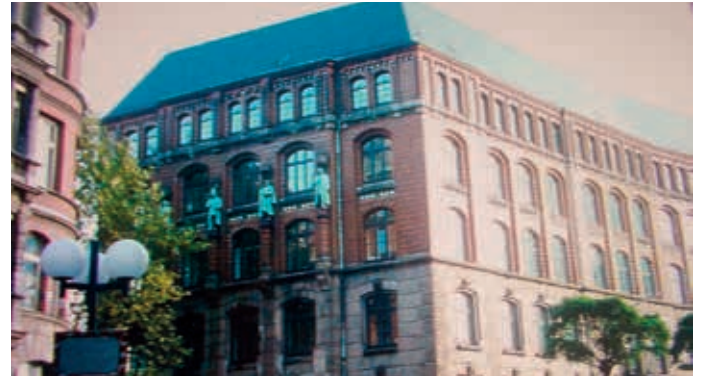
Der „Laeizhof“, Trostbrücke 1
