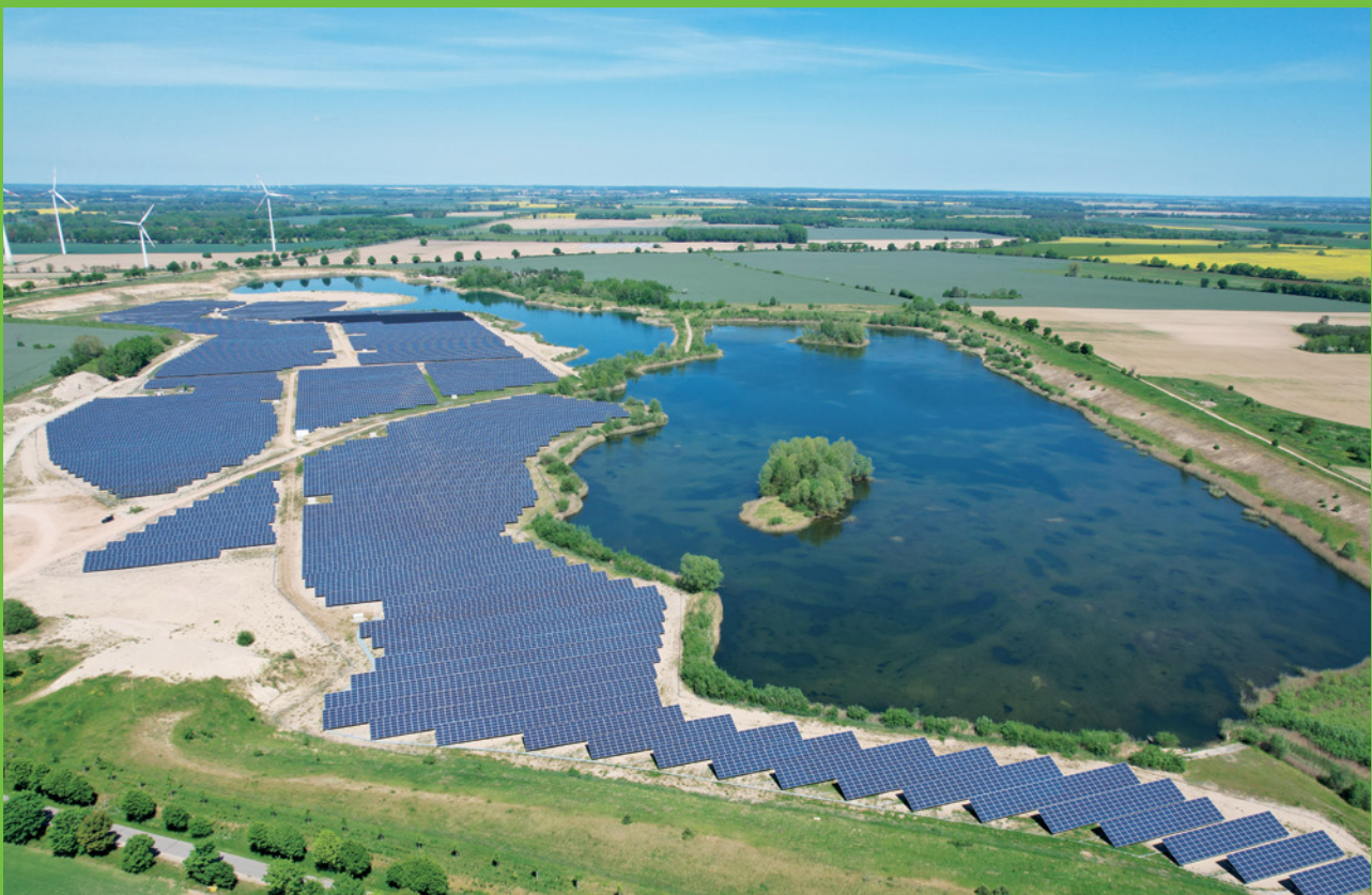
Die Freiflächen-Solaranlage in Wusseken wurde auf dem Gelände eines alten Kieswerks errichtet.
