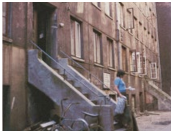
Die Wohnverhältnisse in einigen Hinterhöfen waren nicht mehr zeitgemäß.
