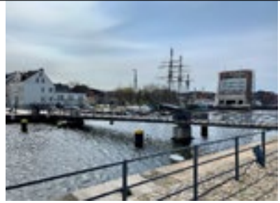
Harburger Binnenhafen (Zitadellenbrücke)
