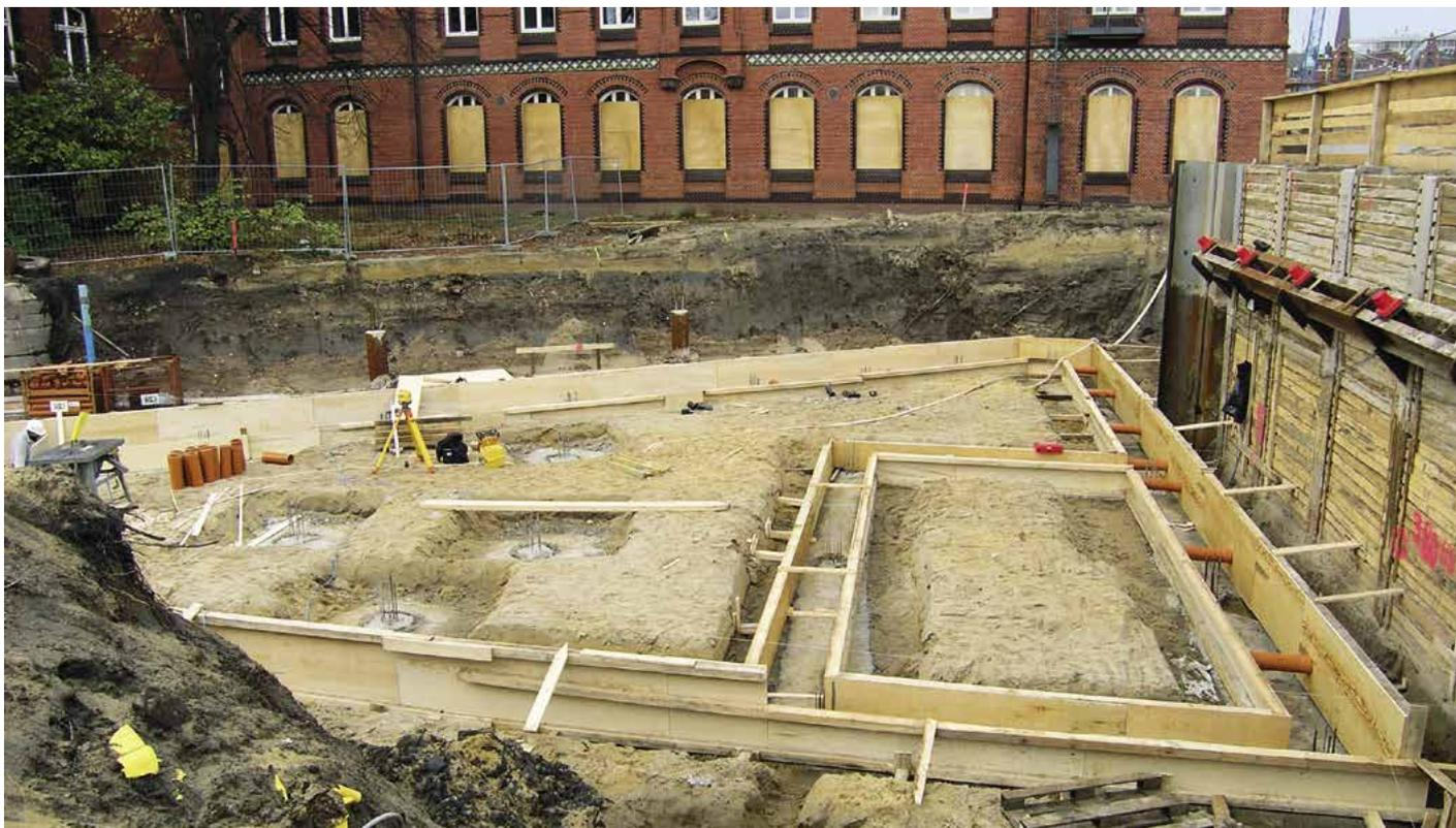
*Einbau der horizontalen Flächendränage und der Fundamentdurchbrüche*
