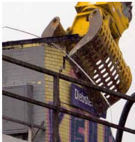
Der Abriss des alten S-Bahnhofs hat begonnen
