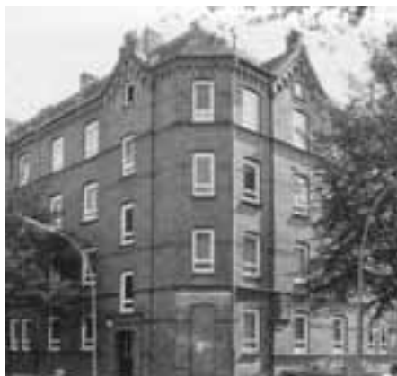
Das Haus zwischen 1972 und 1990: große Fensterscheiben ersetzen die alte Fensteraufteilung, der Ladeneingang ist zugemauert.
