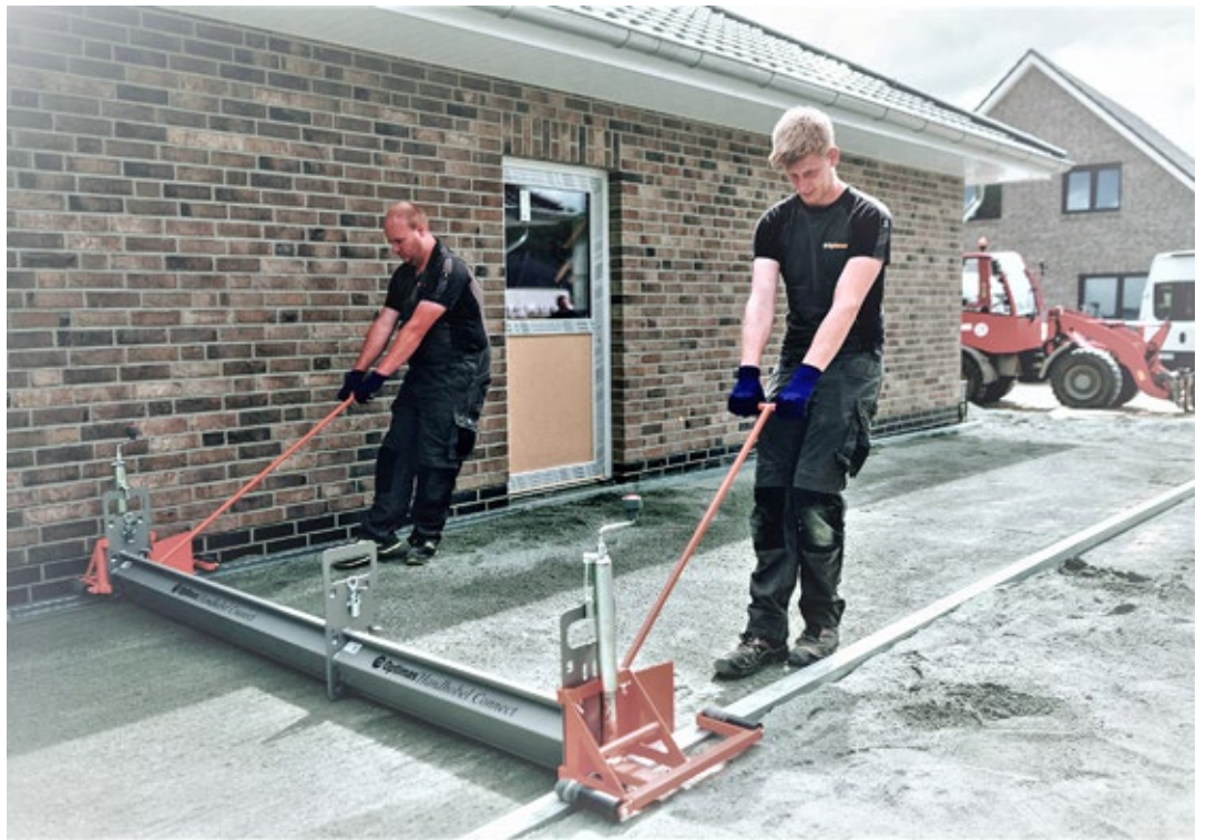
Beim Optimas Connect sind die fünf Zwischenteile einzeln oder kombinierbar zu nutzen. Das neue Steck- und Verschlusssystem lässt stufenlose Einstellungen zu. (Foto: Optimas GmbH)
