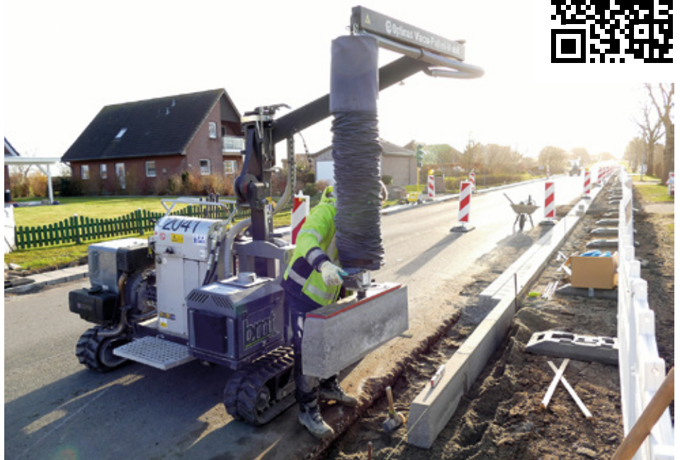
Das Optimas Vacu-Pallet-Mobil verbindet Materialtransport und leichtes Materialhandling durch die Vakuum-Schlauchhebetechnik. (Foto: Optimas GmbH)
