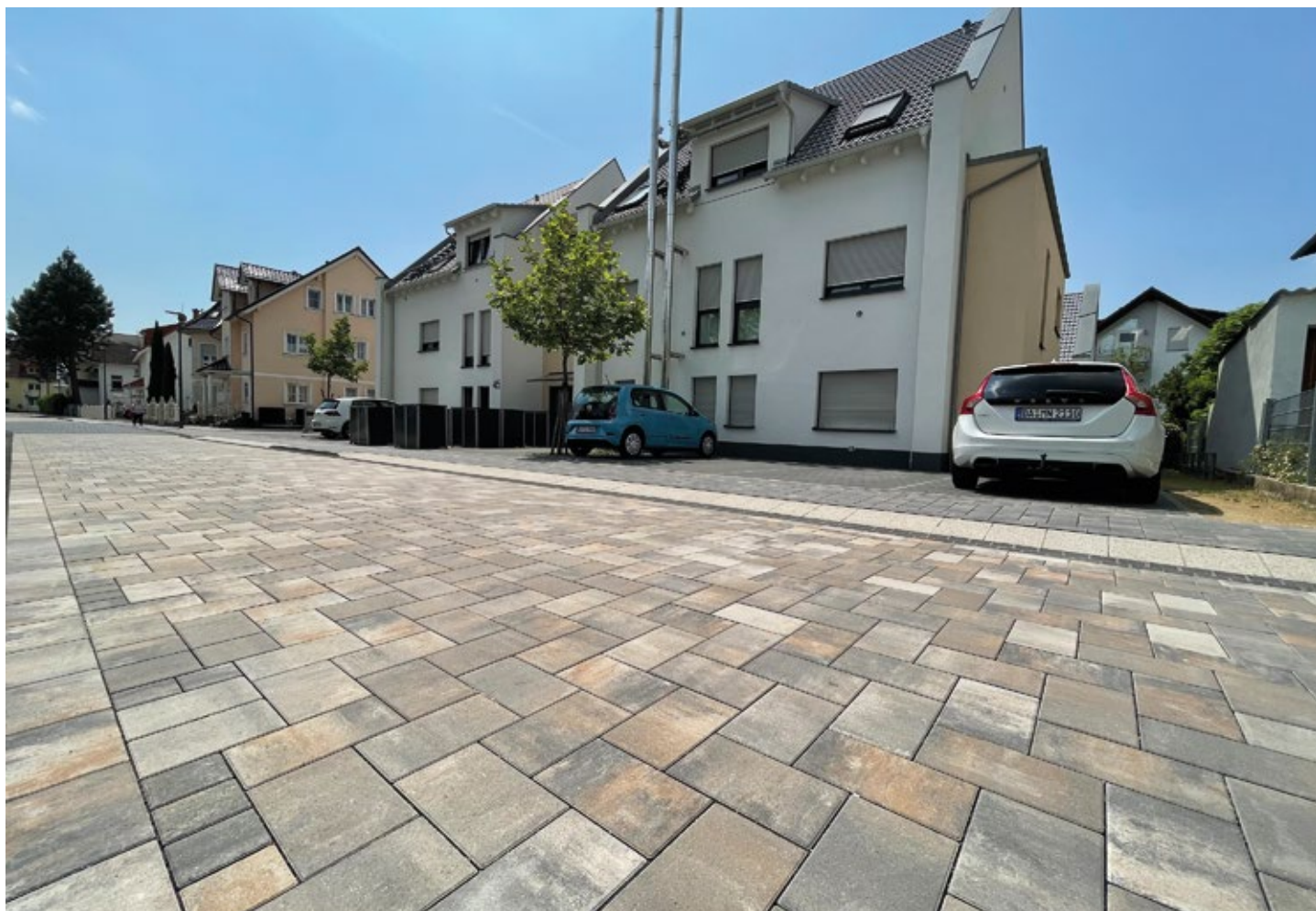
Lässt sich schnell und einfach verlegen: das Pflastersystem CombiConnect mit werkseitig fixiertem EPDM-Profil. (Foto: Beton-Pfenning)
