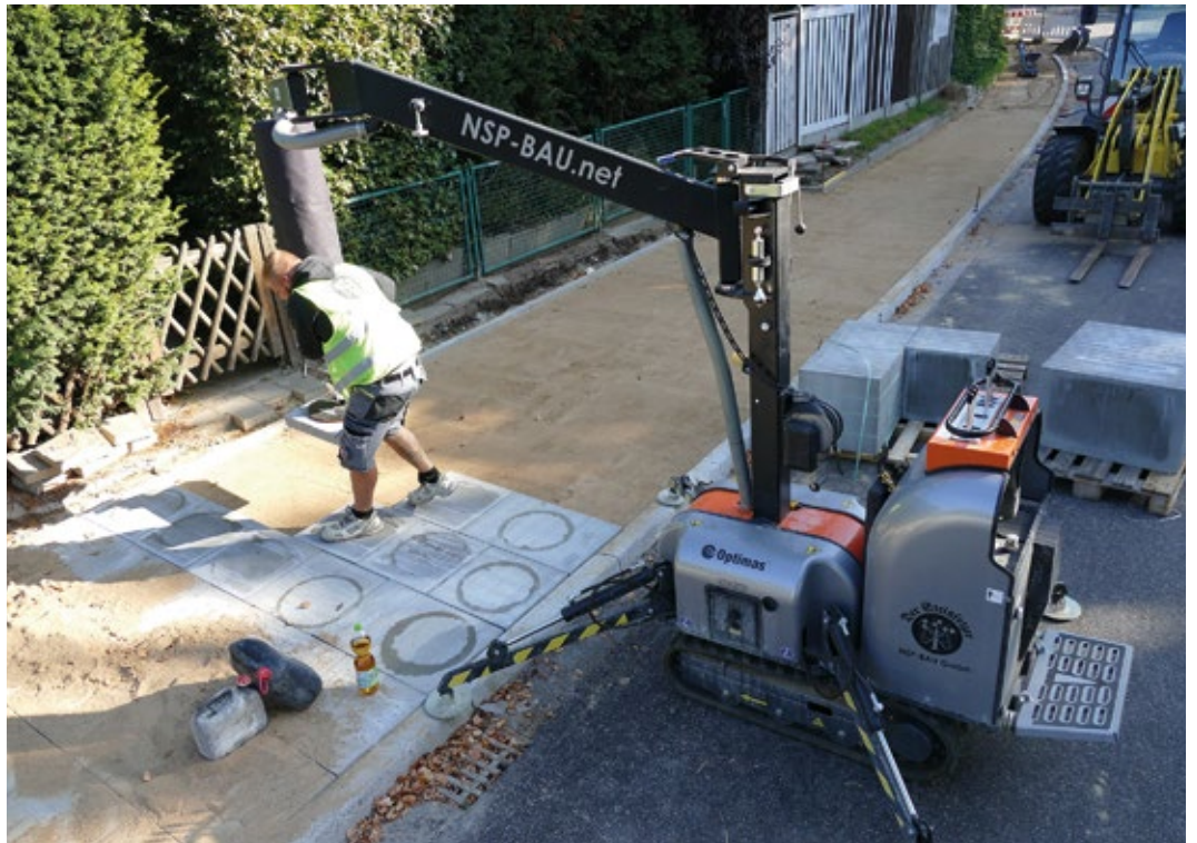
Der Optimas Vacu-Mobil Allrounder macht die Verlegearbeiten von schweren Platten, Hochborden u. v. m. leicht und schnell. (Foto: Optimas GmbH)
