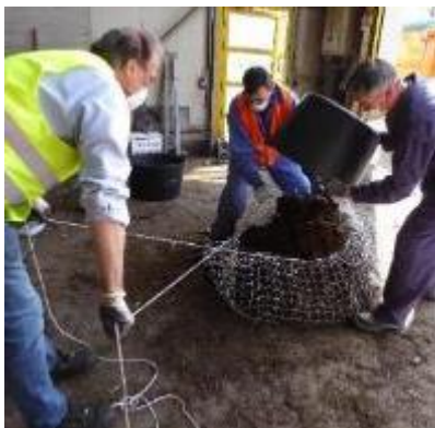
Befüllung und Verschluss der inneren Netzlagen
