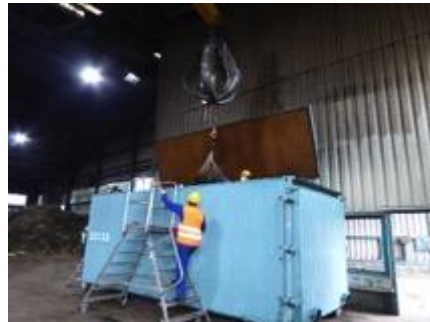
Einbau eines Netzes in einen Container
