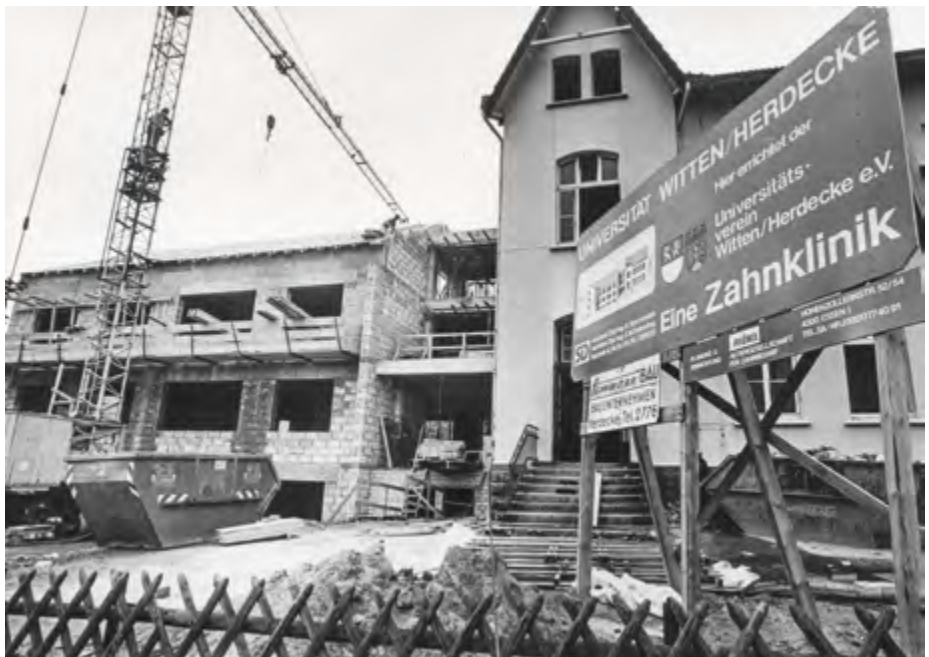
Ein Neubau entsteht in Witten/Herdecke
