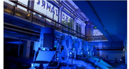
**DAS WASSERWERK GLINDE** versorgt die Hamburger Stadtteile Jenfeld, Billstedt und Lohbrügge sowie die östlichen Randgemeinden über vier Trinkwasserbehälter und sechs Kreislumpen jeden Tag mit 12.000 bis 36.000 m<sup>3</sup> Wasser.
