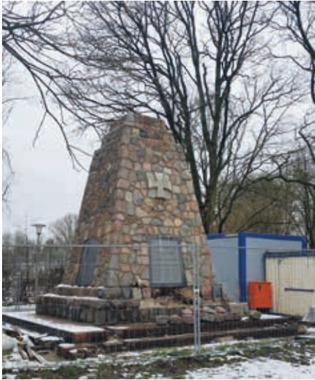
Sanierungsarbeiten im Februar 2021 (Foto Jörg Meyer)
