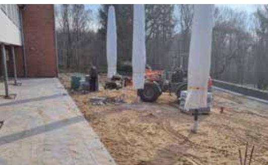
Diese Bauphase endete rechtzeitig vor Saisonbeginn
