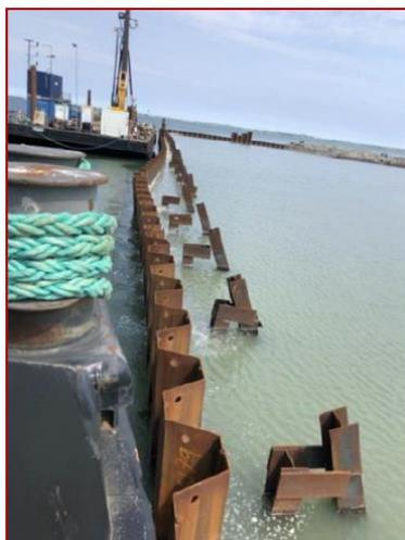
*Abb. 7: Schaden Spundwandabschnitt 4*
