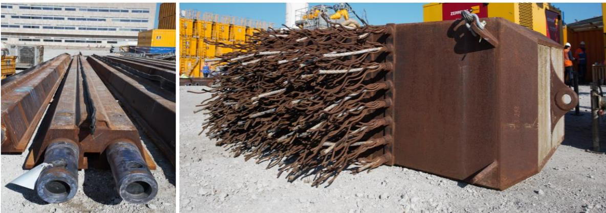
**Abb. 7:** Abschaltbohle mit Fugenband vor dem Einstellen in Primärlamellen (links) sowie „Bürste“ für das Säubern des Fugenbereichs nach dem Ausbau der Abschaltbohle und vor Betonage der schließenden Sekundärlamellen (rechts)
