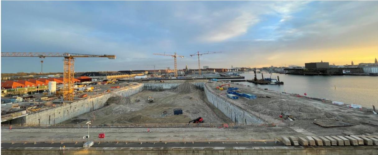
**Abb. 10:** Die Baugrube mit umlaufender Schlitzwand für das Projekt Operaparken in Kopenhagen
