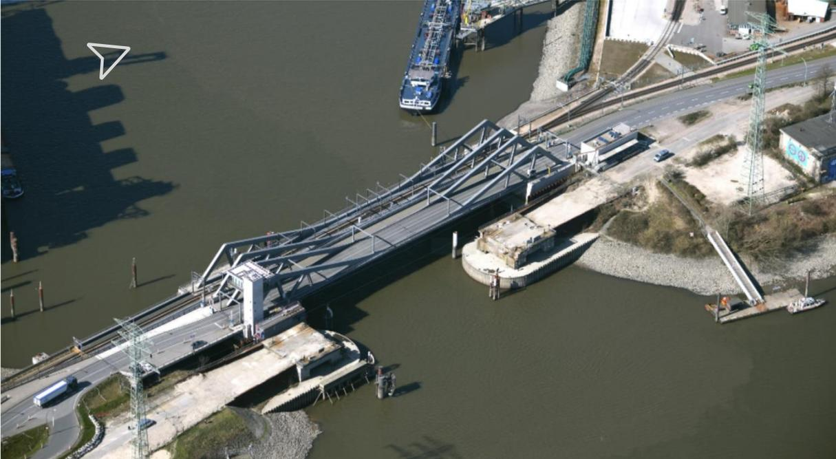
**Abb. 1:** Rethedoppelklappbrücke mit Fundamenten der Rethehubbrücke (Quelle: Falcon Crest/HPA)
