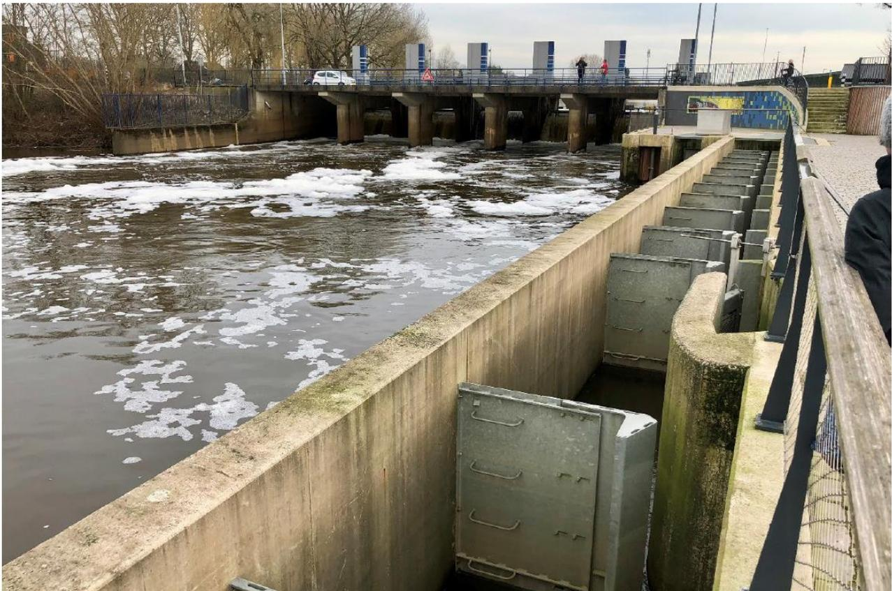
**Abb. 9:** Durchfluss in allen Wehrfeldern bei  $Q = 22 \text{ m}^3/\text{s}$  und  $UW = 7,26 \text{ m} + \text{NAP}$  am 1.3.2022 (Bild: Redeker)
