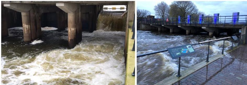
**Abb. 7:** Verschiedene hydraulische Zustände am Wehr/Tosbecken. Links: Vollkommener Überfall und ungestaute Deckwalze unterstrom Wehrfeld 1 am 18.12.2019. Rechts: Unvollkommener Überfall und gewellter Abfluss unterstrom Wehrfeld 1 am 09.03.2020 (Bilder: Redeker)
