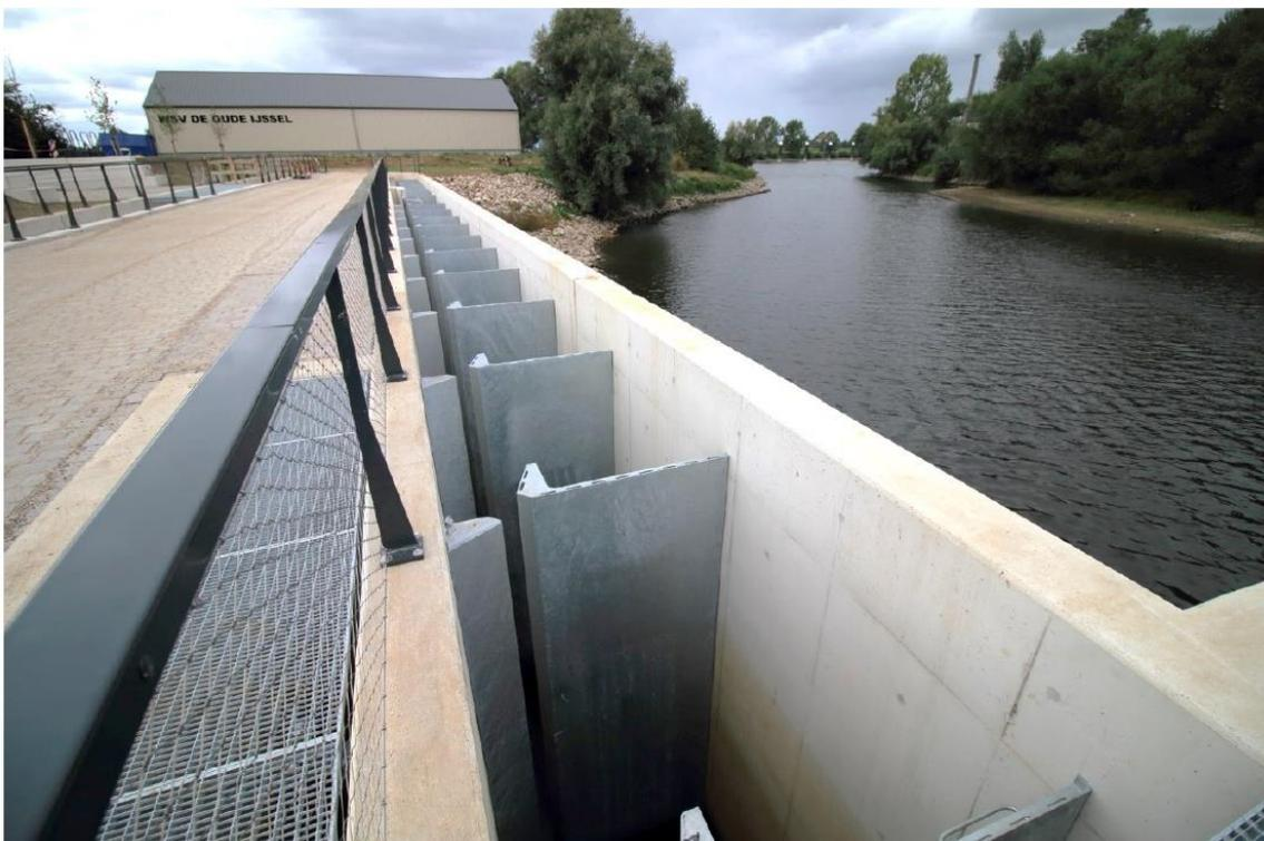
**Abb. 5:** Trennwände wurden zur Reduzierung der Bauwerkslänge in Stahlbauweise ausgeführt (Bild: Redeker, 17.09.2019)
