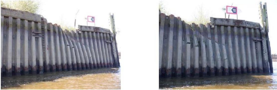
*Abb. 4: Stark verformte Spundwand mit gerissenen Bohlen*
