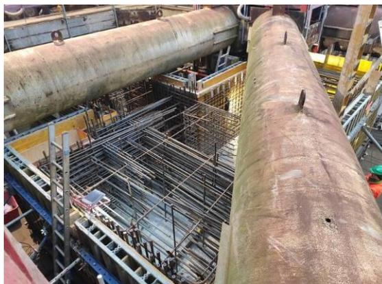
Abb. 13: Herstellung des Massivbaus direkt unterhalb der 1. Aussteifungslage
