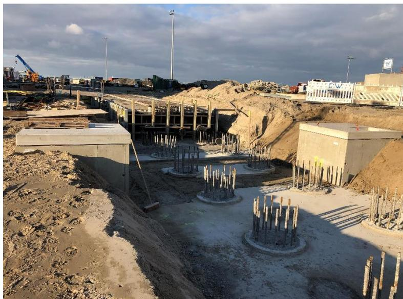
*Abb. 3 Herstellung der Bohrpfahlgründung und Stahlbetonarbeiten*
