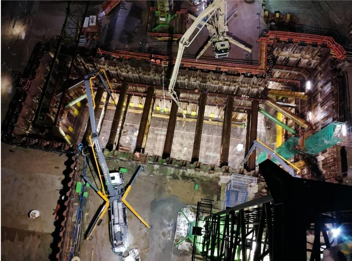
*Abb. 7: Betonage der Massivbausohle mittels 3 Stück 52m Betonpumpen.*
