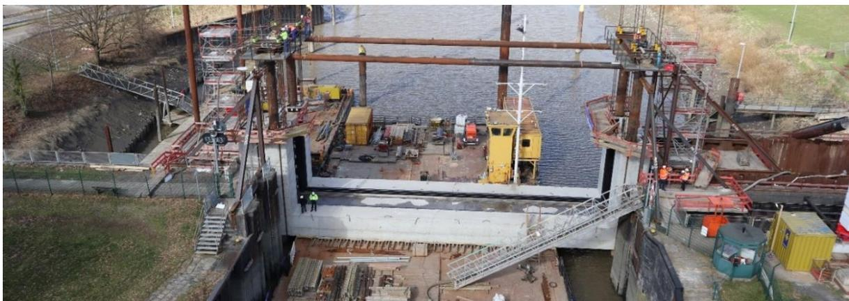
**Abb. 8:** Vorarbeiten für das Absenken des Drempelfertigteils – März 2021
