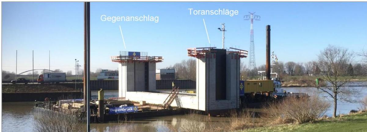
**Abb. 5:** Transport des Drempelfertigteils über die Ems – März 2021
