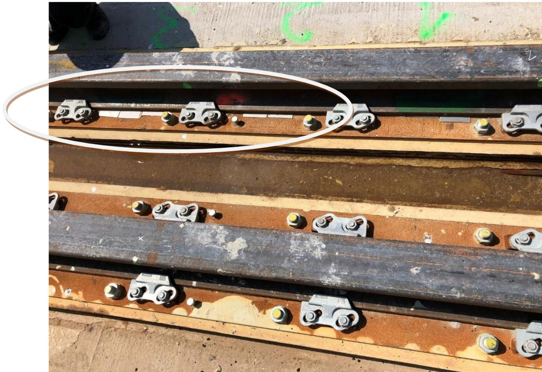
**Abb. 7** Kranschienensystem A 150 mit Unterfütterung
