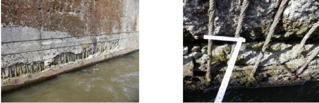
*Abb. 2: Beispiel für Betonabplatzungen und freiliegende Bewehrung*
