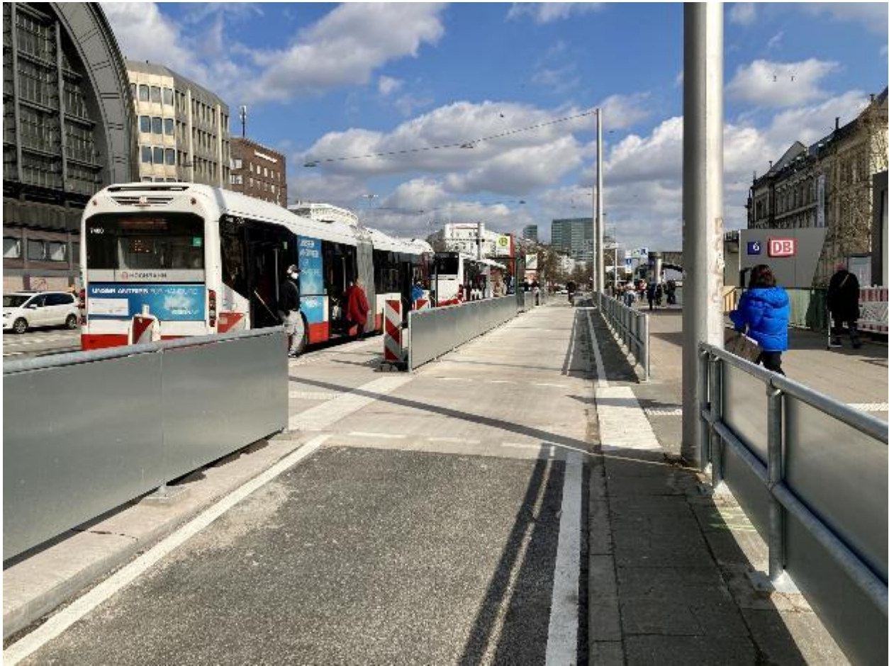
Bild 19: Radverkehrsführung an der Bushaltestelle Hauptbahnhof / Steintorbrücke. © BVM
