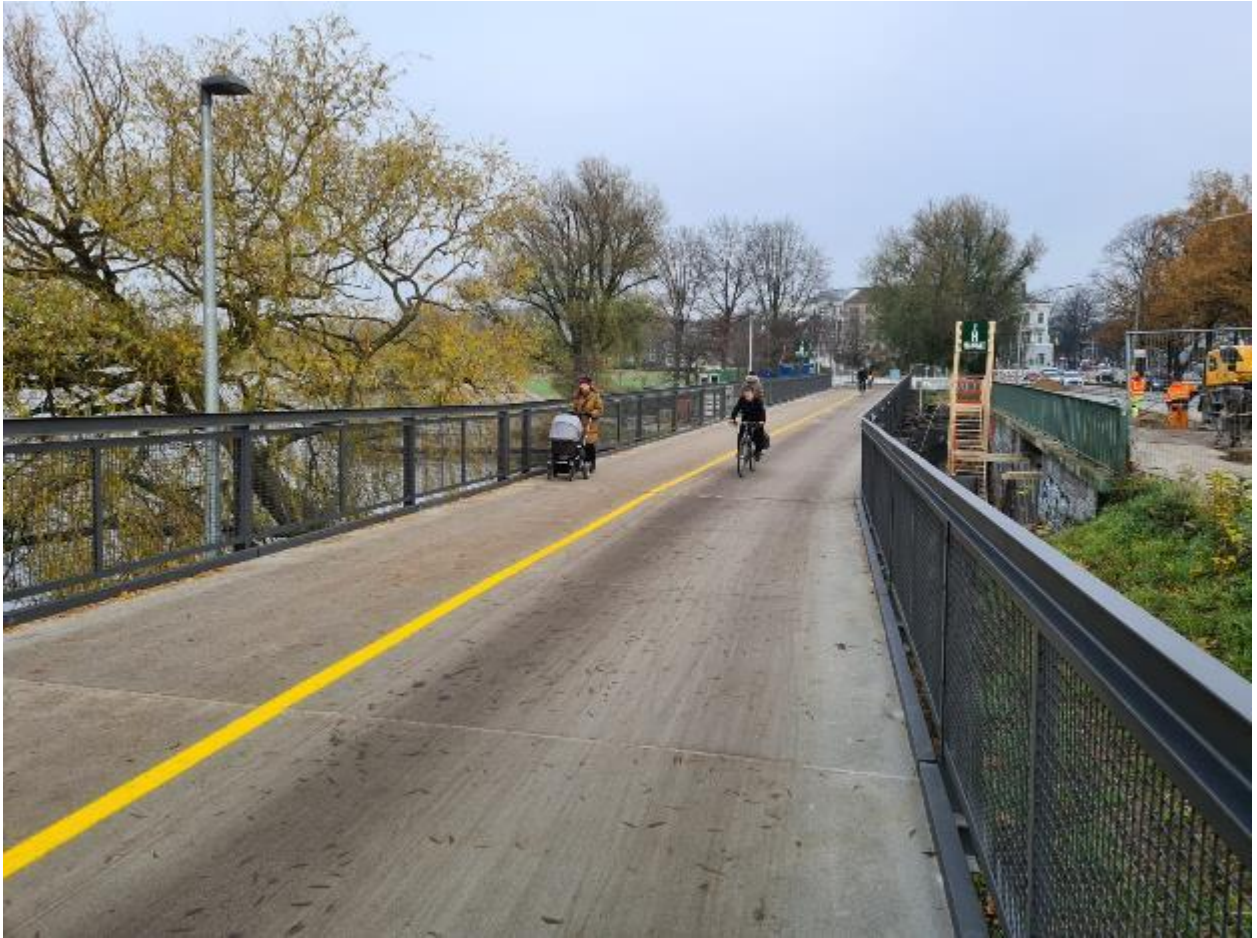
Bild 21: Behelfsbrücke Hohenfelder Bucht. © BVM
