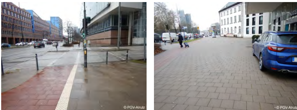
Abb. 5-2 Taktile Elemente am Radweg am Knotenpunkt Ludwig-Erhard-Straße/ Englische Planke (links); je nach Lichtverhältnissen kaum wahrnehmbarer Unterschied zwischen Gehweg und Radweg, Ludwig-Erhard-Straße (rechts. Quelle: PGV-Alrutz)
