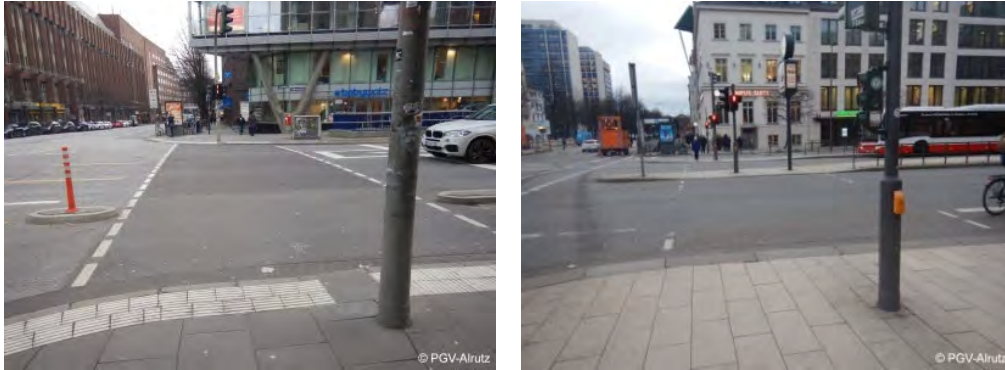
Abb. 5-1 Taktile Elemente am Knotenpunkt Valentinskamp / Caffamacherreihe (links); Vibrationstaster am Knotenpunkt Stephansplatz (rechts. Quelle: PGV-Alrutz)
