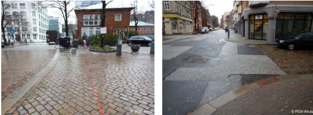
Abb. 5-4 Sichtbehinderung auf Fußgängerüberweg, hier durch Müllcontainer für Kfz in der Gegenrichtung durch Lieferfahrzeug, Englische Planke (links); glatter Fahrbelag an Querungsstelle über einmündende gepflasterte Fahrbahn, Kohlhöfen/ Brüderstraße (rechts. Quelle: PGV-Alrutz)
