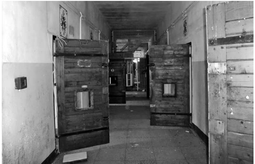
Zellenbau in der Oberetage des Hafthauses, in dem vermutlich Fallada untergebracht war
