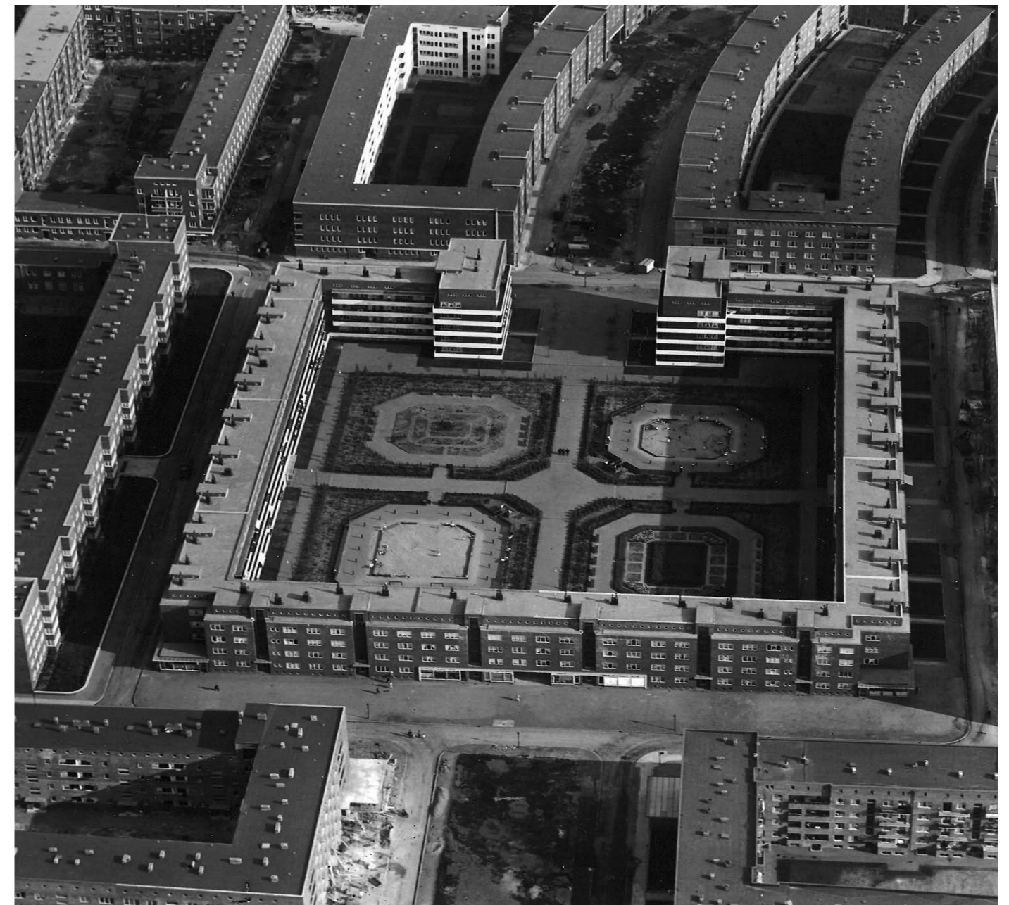
Bild 04: Jarrestadt, Zentraler Block kurz nach Fertigstellung
