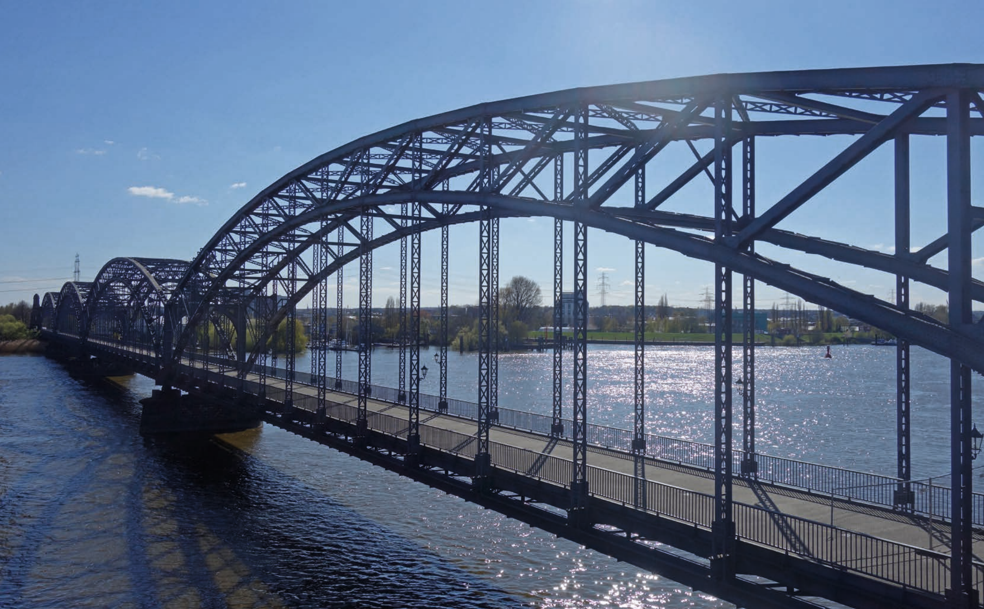
Alte Harburger Elbbrücke
