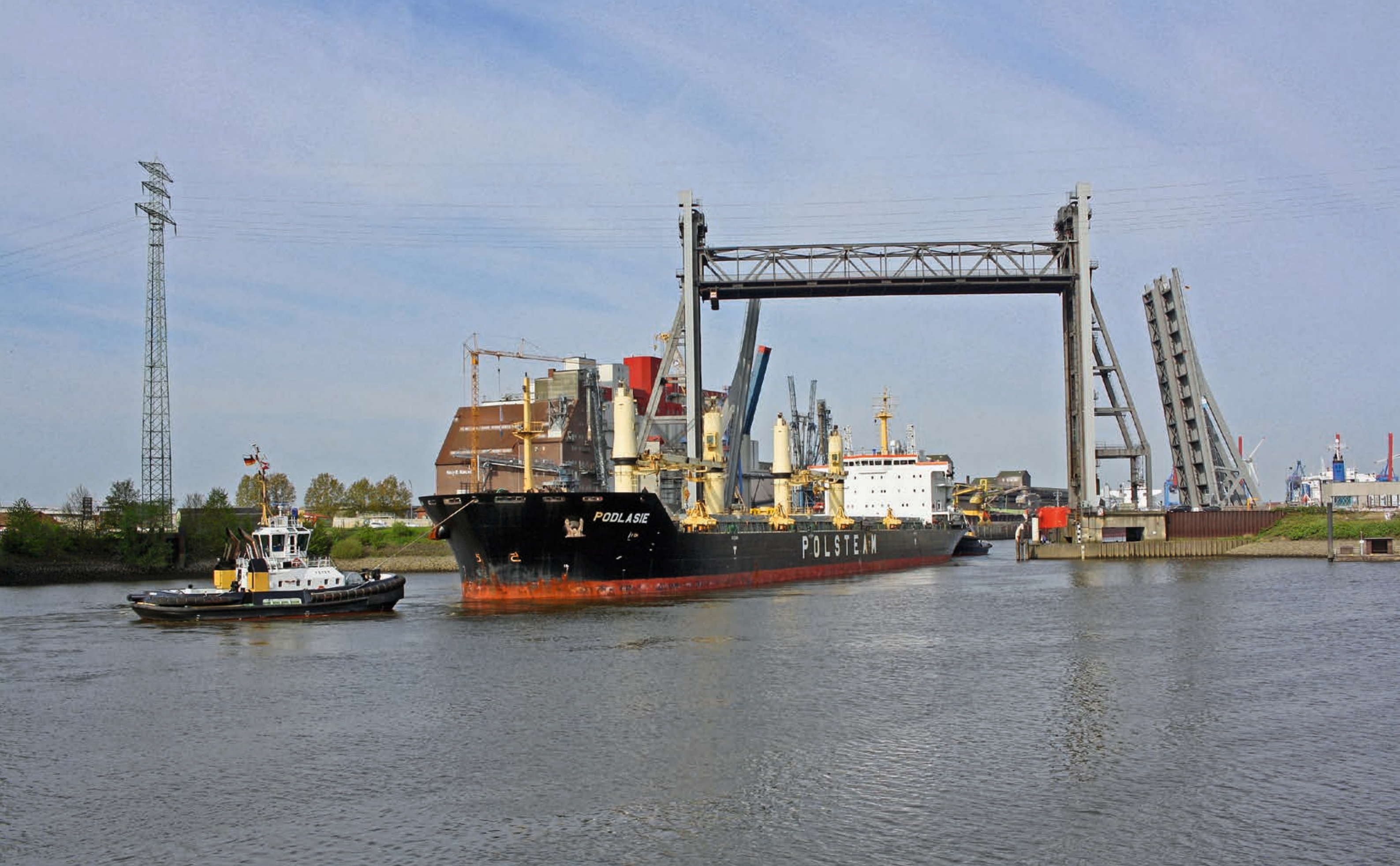
Alte und neue Rethebrücke
