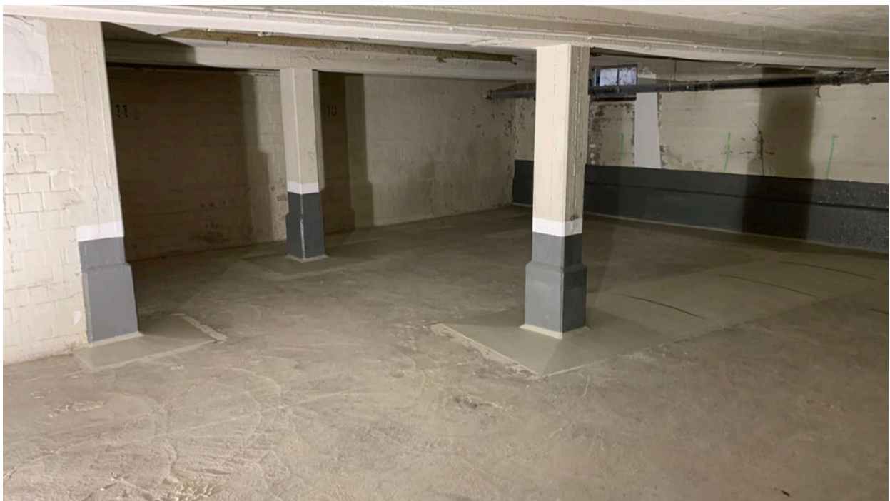
Tiefgarage Schwarzenbergstraße 58 – Betonsanierung abgeschlossen
