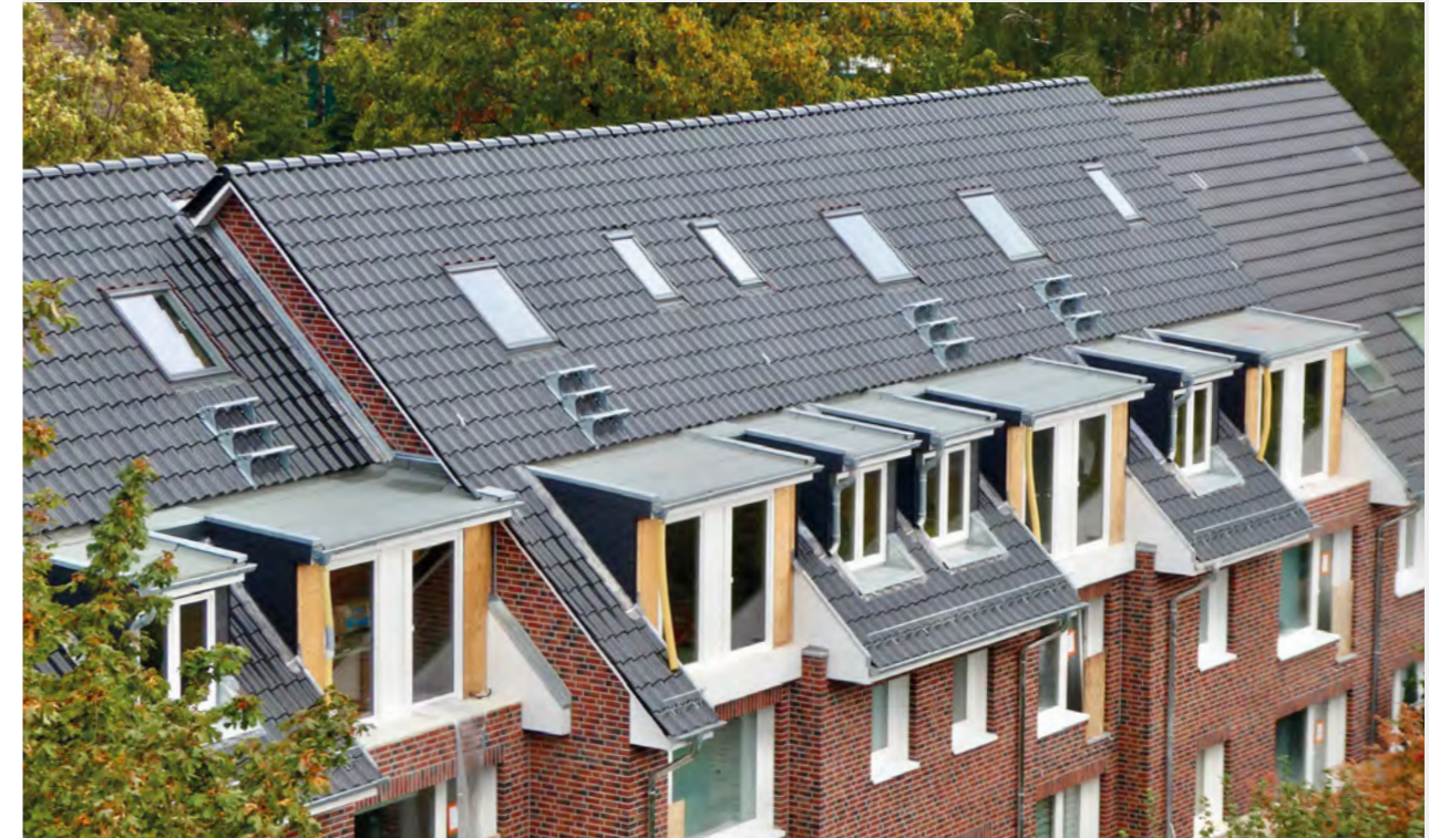
Die im Dachgeschoss neu entstandenen Maisonettewohnungen kurz vor der Fertigstellung
