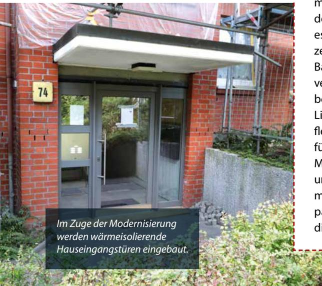
*Im Zuge der Modernisierung werden wärmeisolierende Hauseingangstüren eingebaut.*
