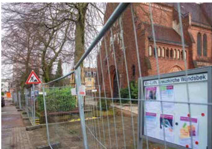
Für die Sanierungsarbeiten des Außengeländes wurde der Bereich vor der Kreuzkirche abgesperrt. Foto: Kreuzkirche
